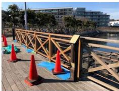
手摺や栈橋デッキの塗装作業（美観と劣化防止）
