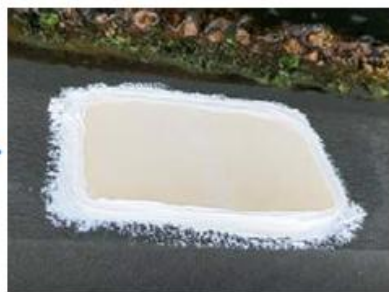
栈橋フロートの損傷（補修後）
