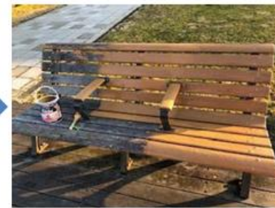
芝生広場のベンチの補修（補修後）
