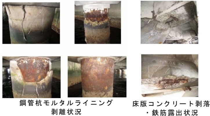
図 5-3-2 横須賀港の各施設（-4.5m 以深）の利用状況と老朽化の状況
