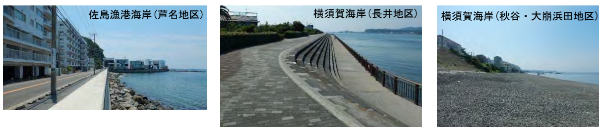
図-1.14 整備状況写真
