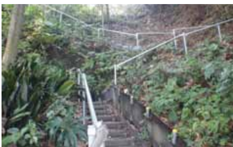
避難路の整備（横須賀市内）
