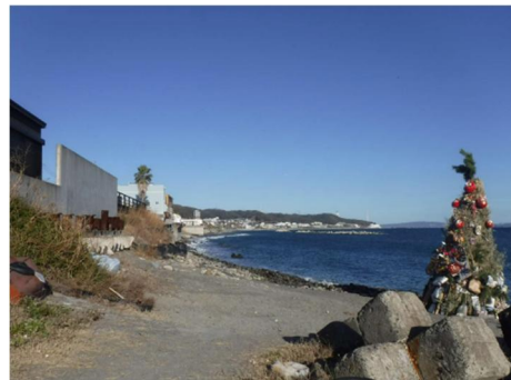
北下浦漁港東側の侵食状況 (R6/1/9)
