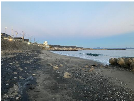
離岸堤開口部の汀線状況 (R5/12/23)
