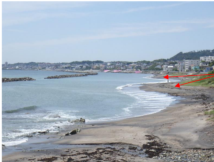
離岸堤背後の砂の堆積状況（R6/5/14）
