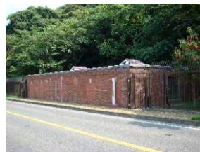
走水水源地 (市内)
