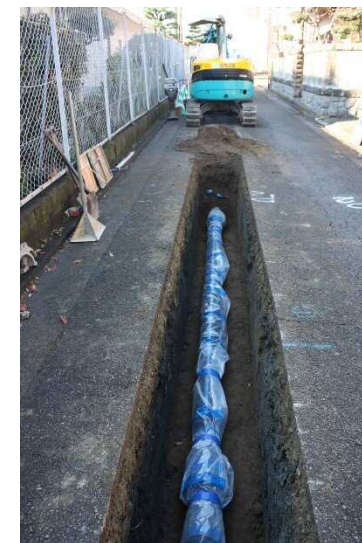
配水管更新工事現場
