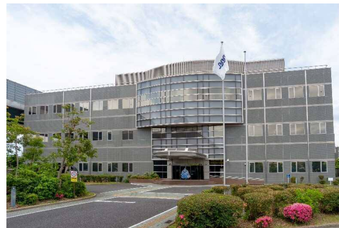
広域水質管理センターがある 社家取水施設管理棟
