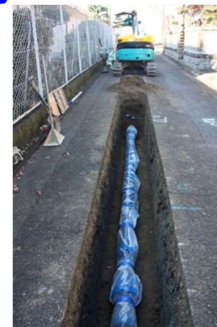
配水管更新工事の現場
