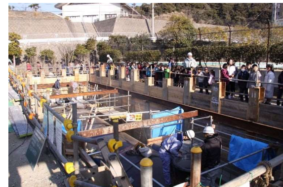
工事見学会の様子
