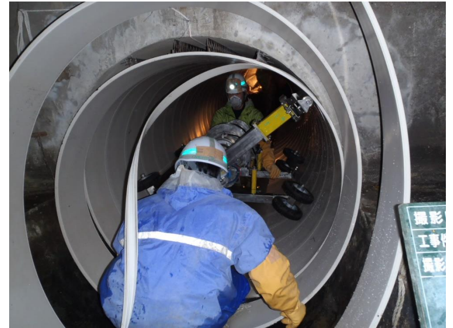
更生工法による改築
