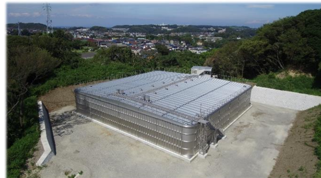
配水池の更新工事（久里浜）
