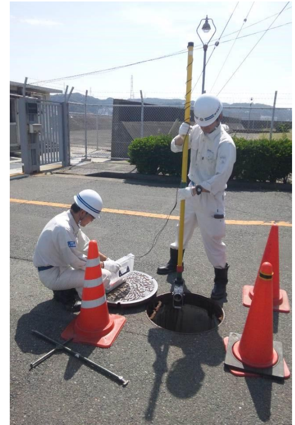
管口カメラによる点検調査
