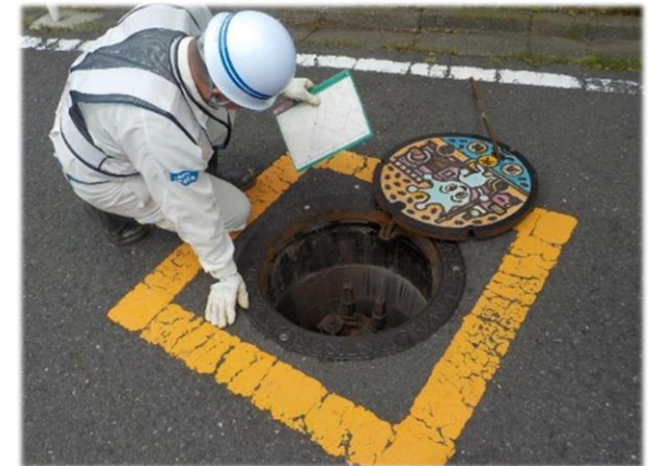
管付属設備の点検
