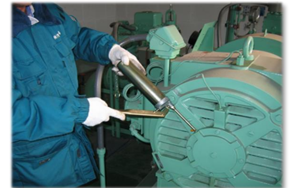
電動機の点検・修繕の様子
