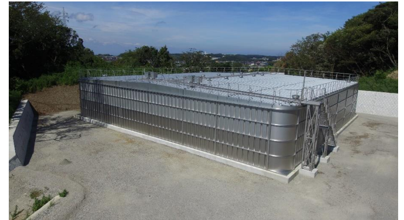
配水池の更新（久里浜配水池）
