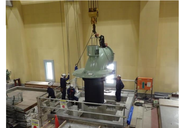
ポンプ設備の改築
