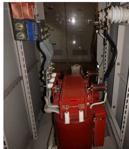
水処理施設の動力変圧器の交換例
