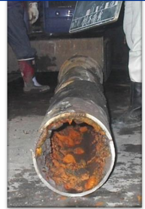
老朽化した水道管
