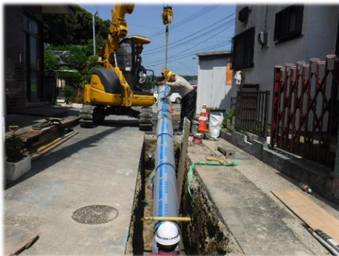
水道管の布設工事現場
