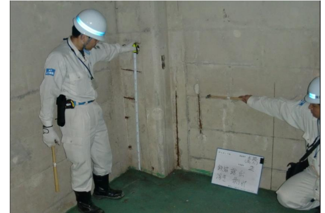
構造物の点検
