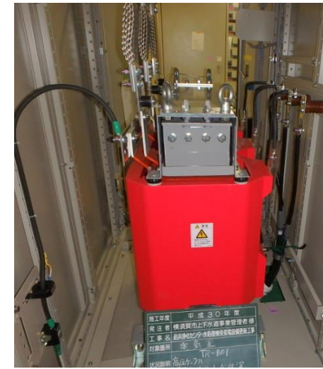
水処理施設の動力変圧器の交換例
