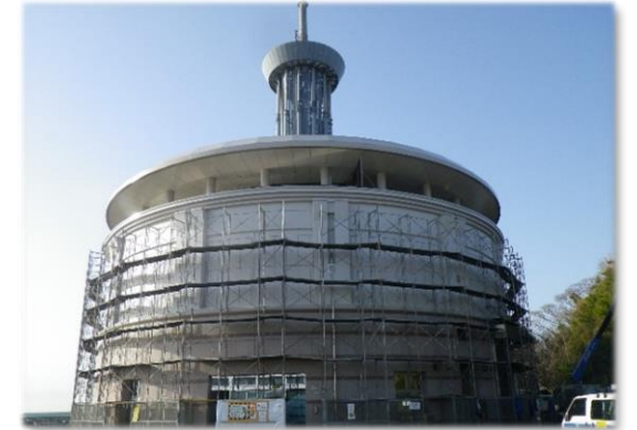
外壁の改修工事例（国際村配水池）
