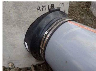
耐震性能を有する下水道管の接続部分
