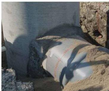
耐震性能のない下水道管の接続部分
