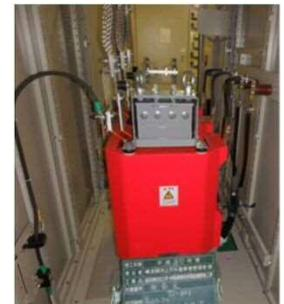
高効率機器への交換事例（動力変圧器の更新）
