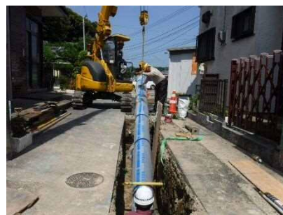
水道管の布設工事現場
