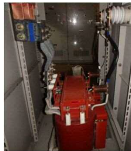
高効率機器への交換事例 (変圧器の更新)
