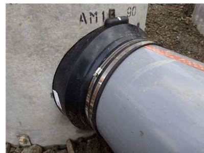
耐震性能を有する下水道管の接続部分 (揺れにあわせて曲がって外れない)
