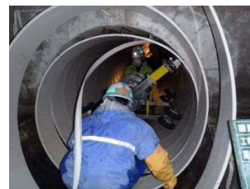
更生工法※31による改良
