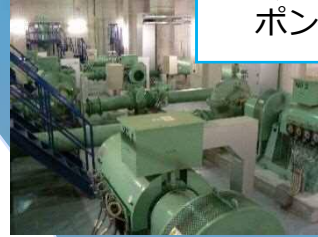
水道水を貯める 配水池
