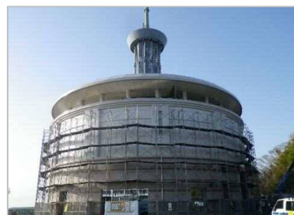
湘南国際村配水池の外壁修理
