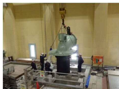
ポンプ設備の更新
