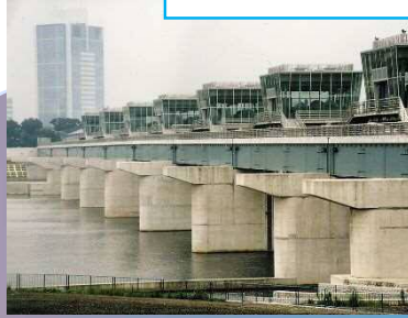
水を取る 取水施設
