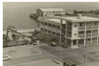
日の出ポンプ場 (昭和41年(1966年)建設)
