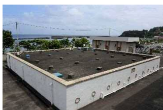
走水配水池 (明治41年(1908年)建設)
