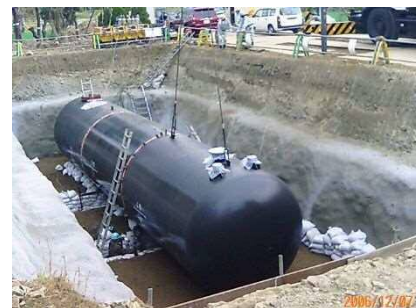
非常用貯水装置の設置
