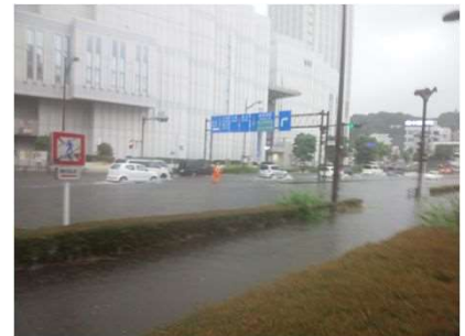
道路冠水（国道16号）
