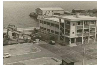
日の出ポンプ場 (昭和41年(1966年)建設)
