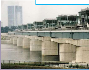
水を取る 取水施設
