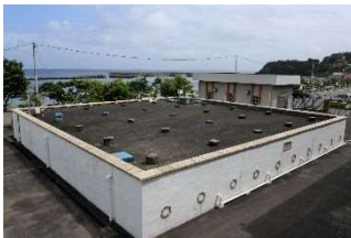
走水配水池 (明治41年(1908年)建設)
