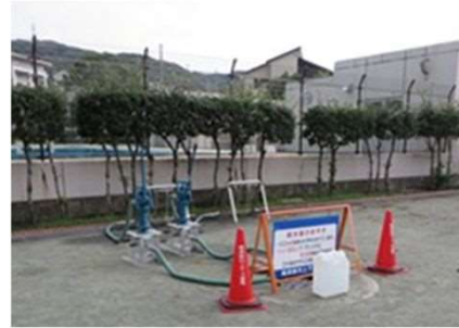
学校での応急給水拠点開設
