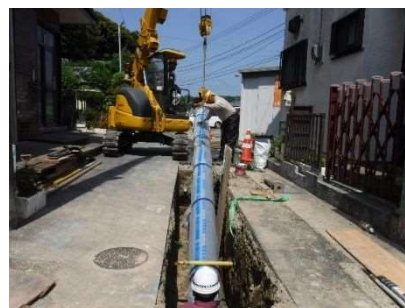
水道管の布設工事現場
