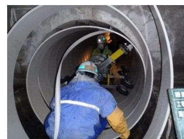
更生工法※31による改良
