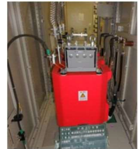
高効率機器への交換事例（変圧器の更新）
