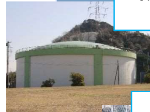
水道水を送る 水道管
