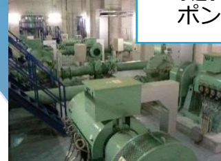
水道水を貯める 配水池
