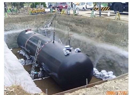
非常用貯水装置の設置
