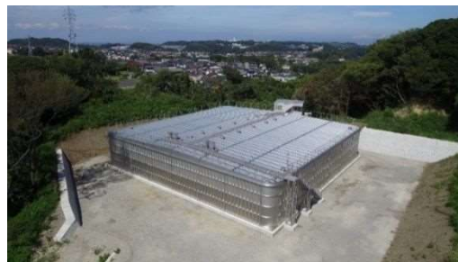
更新後の久里浜配水池 (容量6,000m 3 →4,000m 3 に縮小)
