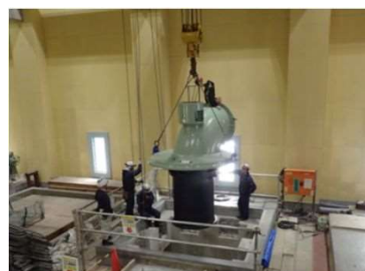
ポンプ設備の更新
