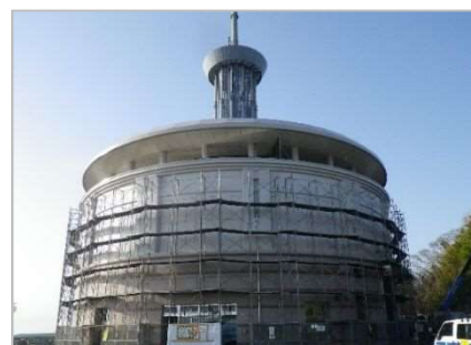
湘南国際村配水池の外壁修理
