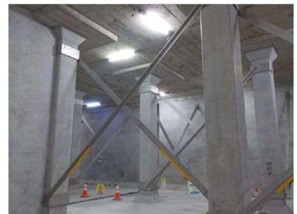
配水池耐震化工事 (小雀配水池)
