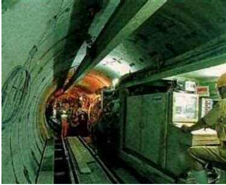
シールド工事
