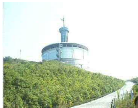
湘南国際村配水池
