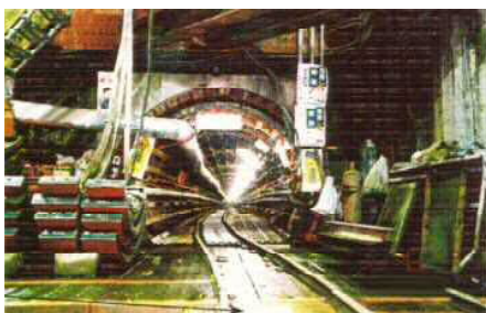
馬堀排水区雨水幹線工事（シールド工法）
