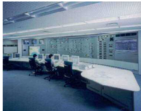
逸見総合管理センター管理室
