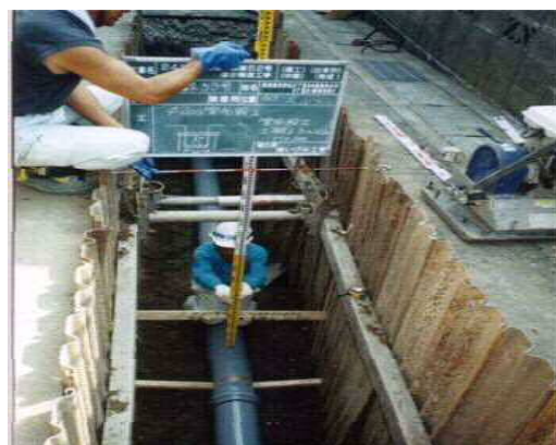
下水(汚水)管の布設状況
