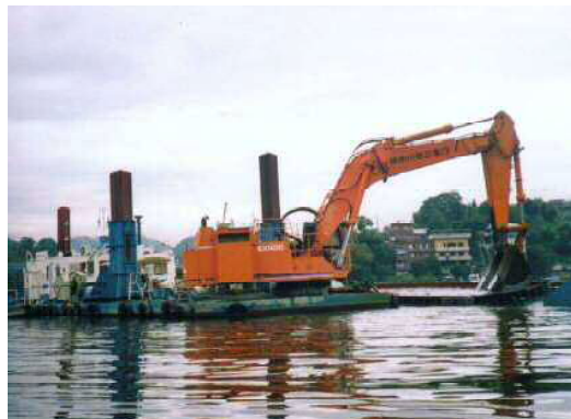
バックホウ浚渫船によるしゅん濇作業
