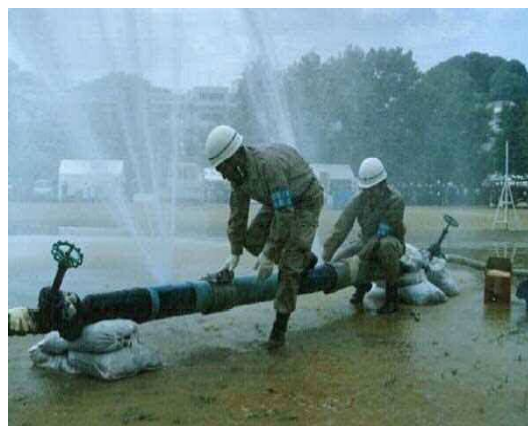
漏水修理訓練
