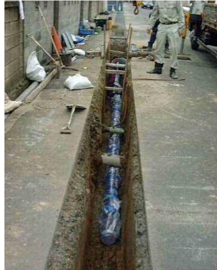
配水管布設工事
