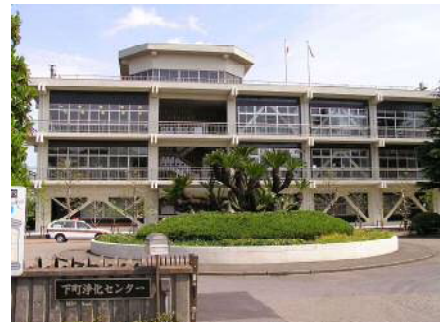
下町浄化センター管理棟耐震補強完成
