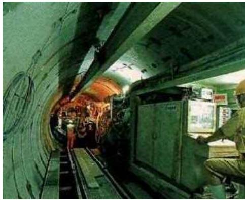
シールド工事
