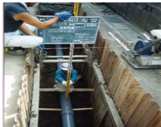
下水(汚水)管の布設状況
