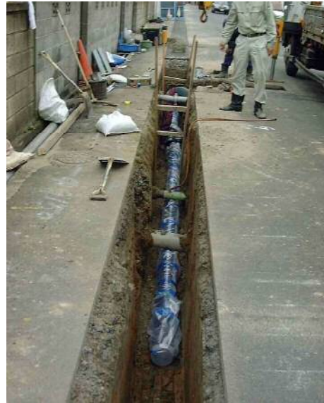
配水管布設工事
