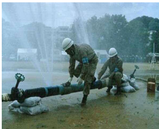
漏水修理訓練
