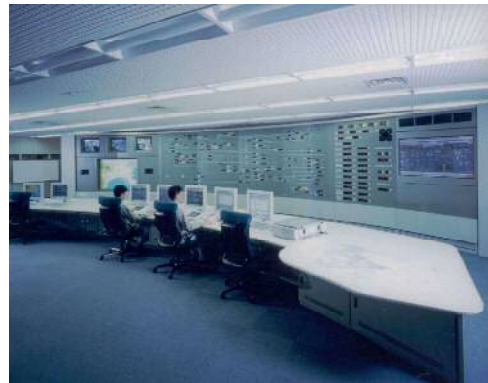
逸見総合管理センター管理室
