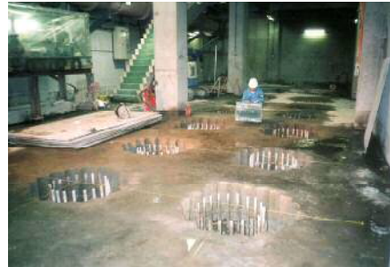
下町浄化センター管理棟耐震補強工事
