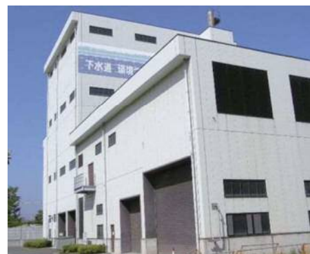
汚泥焼却炉内の機器の冷却水として使用
