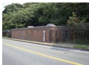
走水水源地煉瓦造貯水池 (国登録有形文化財)
