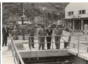
上町下水処理場 (現上町浄化センター) 通水式 (1965年(昭和40年)6月)
