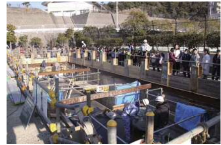
工事現場見学会
