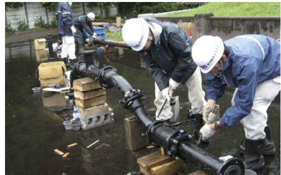
配管作業実習
