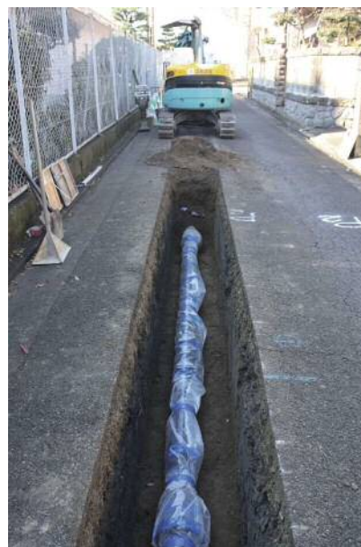
配水管布設工事現場
