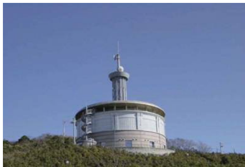
湘南国際村配水池
