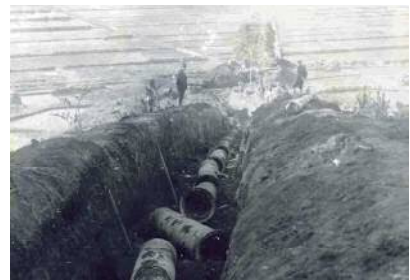
関東大震災の災害復旧工事
