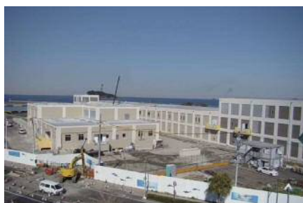
下町浄化センター新系列建設工事
