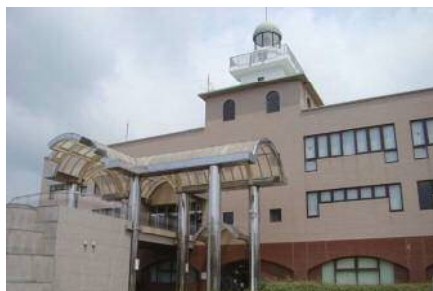
西浄化センター
