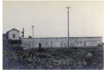
完成当時の走水貯水池
