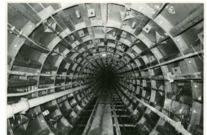
セグメント工法による下町配水幹線内部
