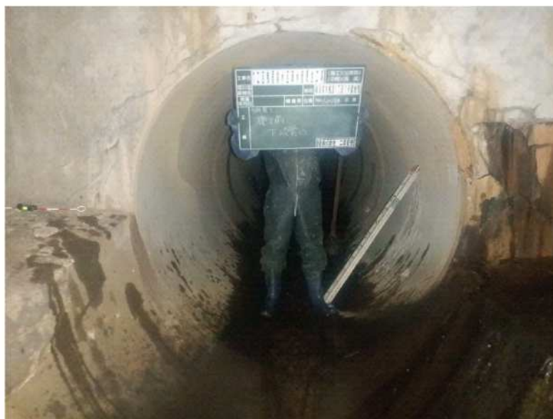
耐震化更生工事 施工前
