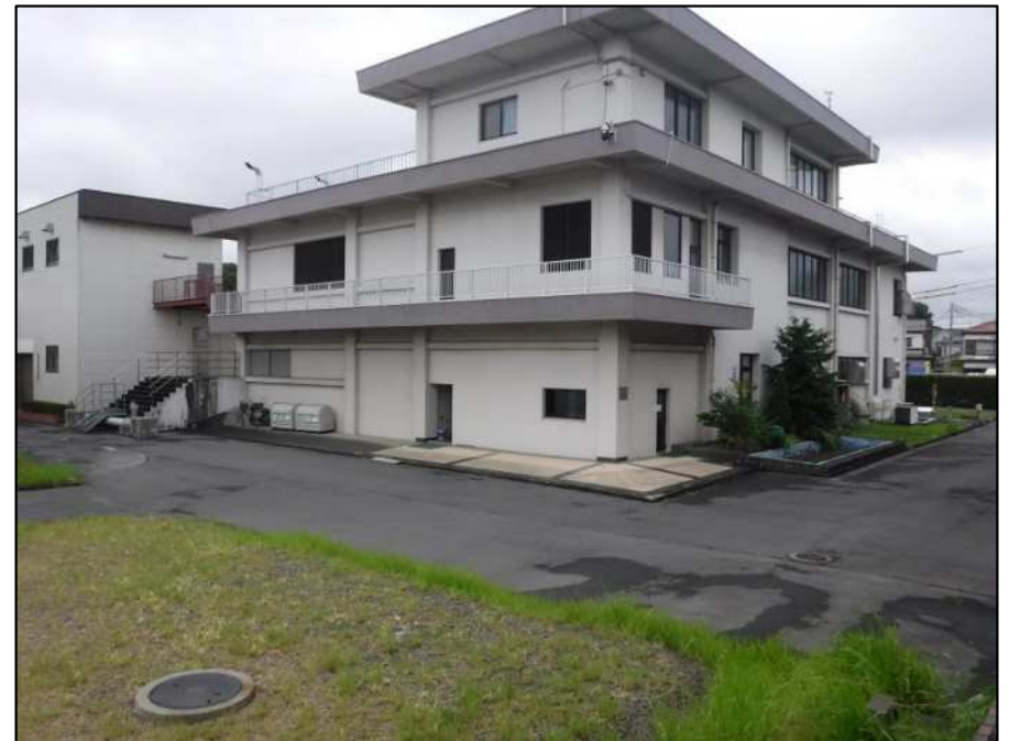
上町ポンプ場
