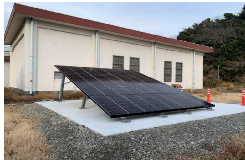
長沢低区配水池太陽光発電設備設置
