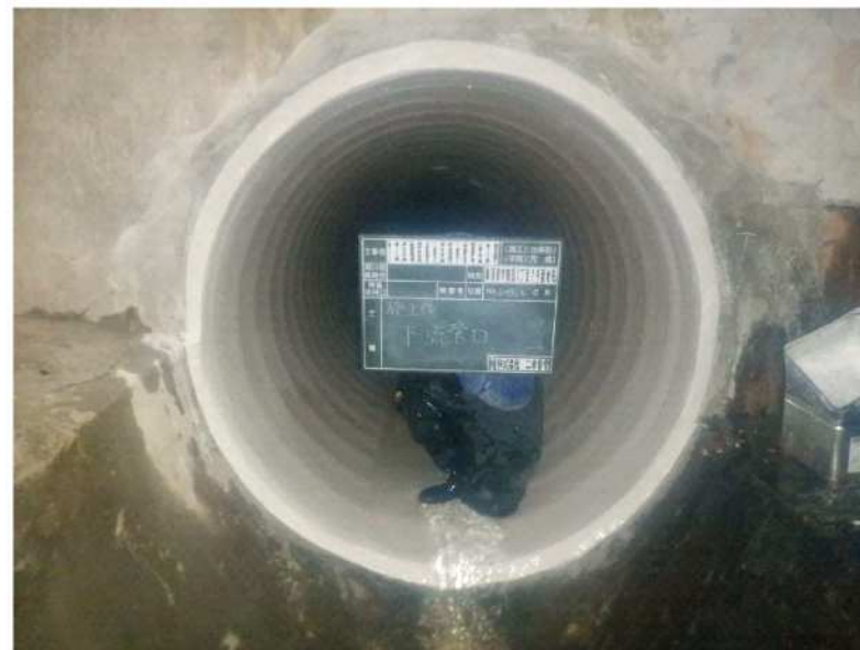
耐震化更生工事 施工後
