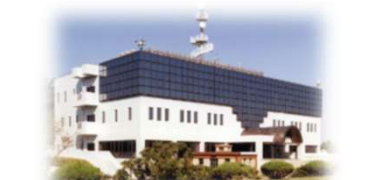
(逸見総合管理センター)
