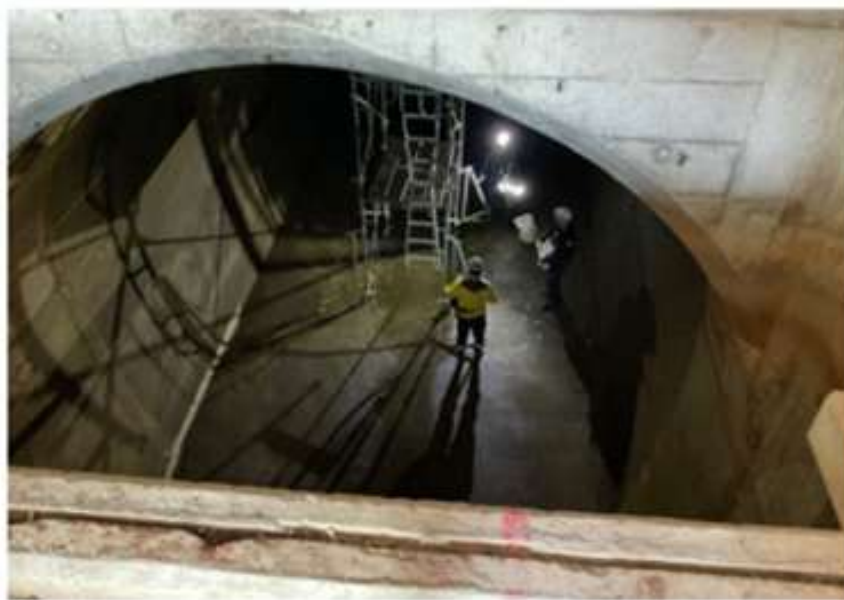
池上ずい道配水池
