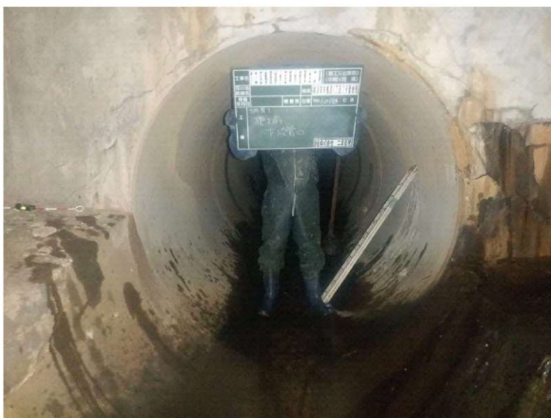
耐震化更生工事 施工前
