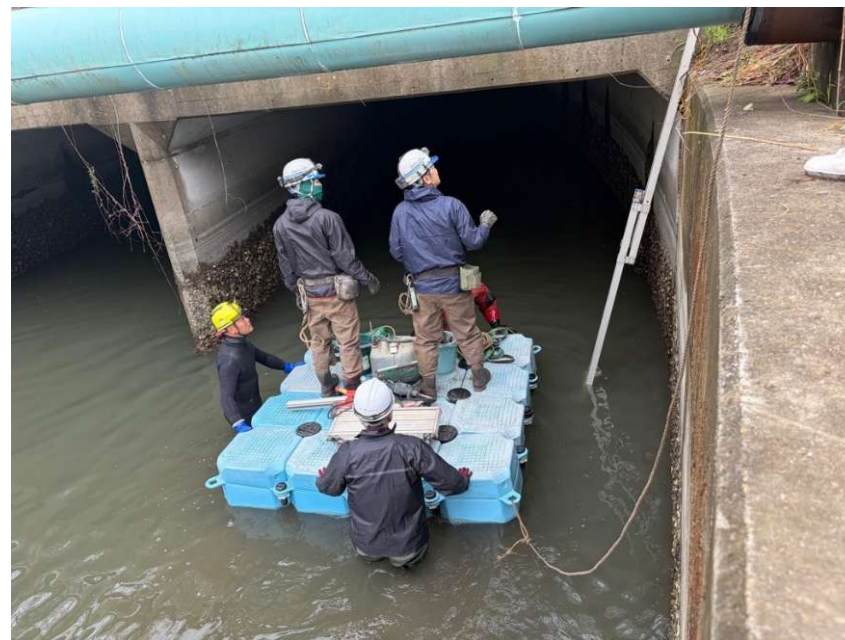
下水道管路特別重点調査に伴う改築設計業務委託
