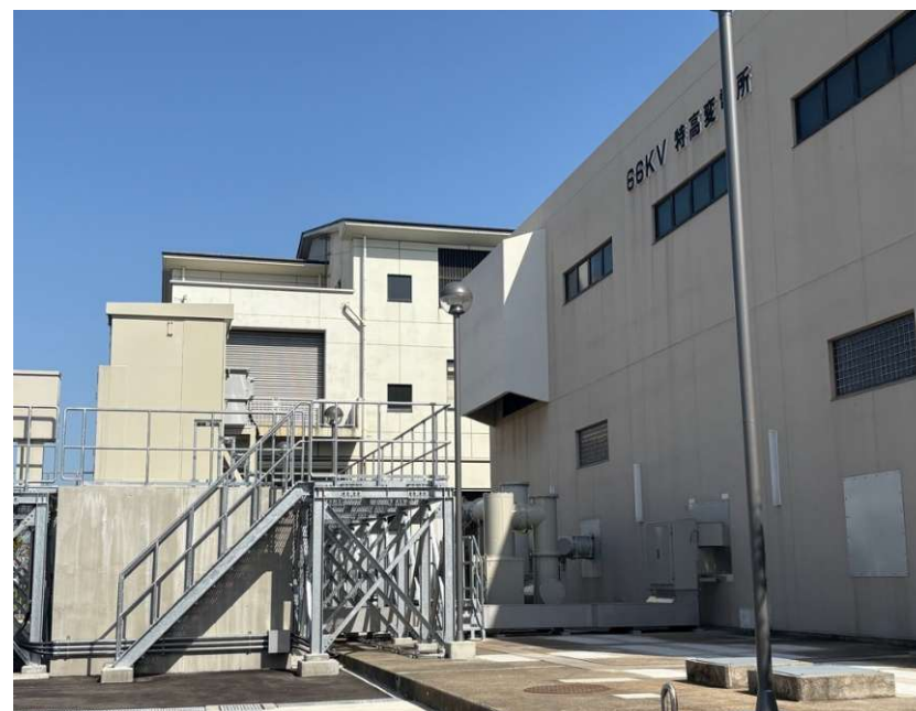
下町浄化センター特高受変電設備更新工事
