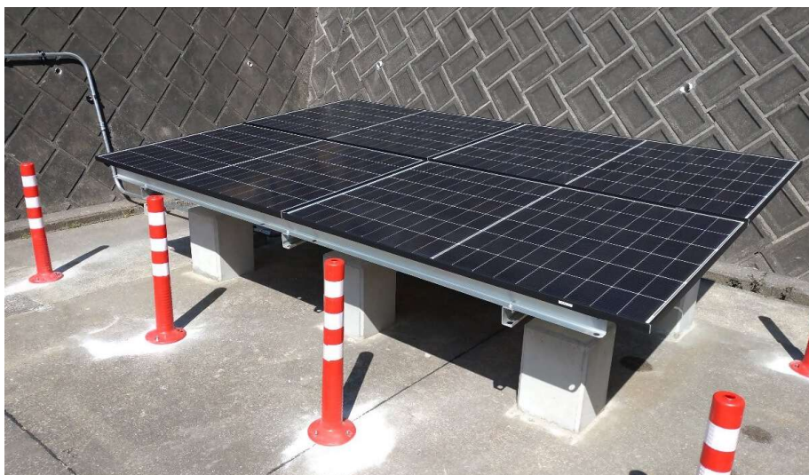
野比高区ポンプ所太陽光発電設備
