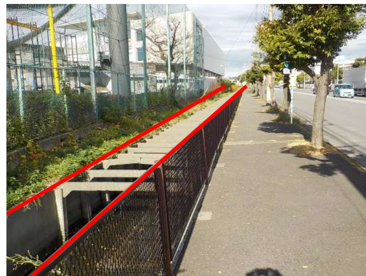
国道357号延伸工事に伴う雨水管整備
