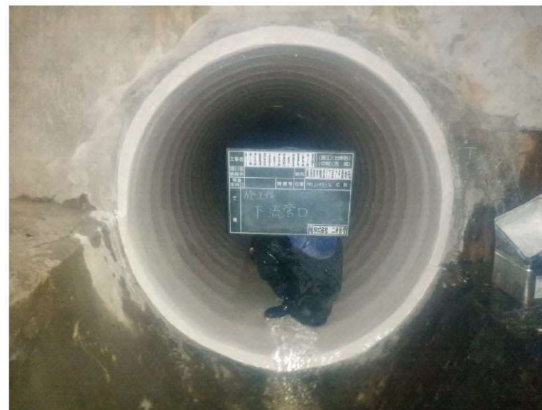
耐震化更生工事 施工後
