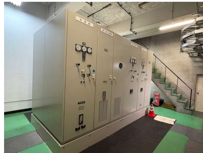
上町ポンプ場管理棟受変電設備ほか更新工事
