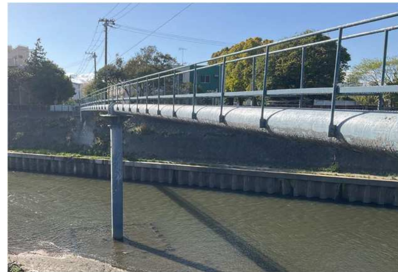
柏尾川水管橋
