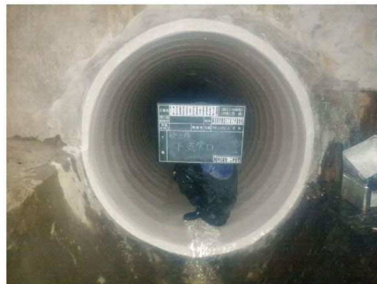
耐震化更生工事 施工後
