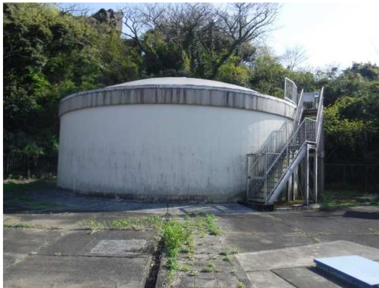
鷹取低区配水池
