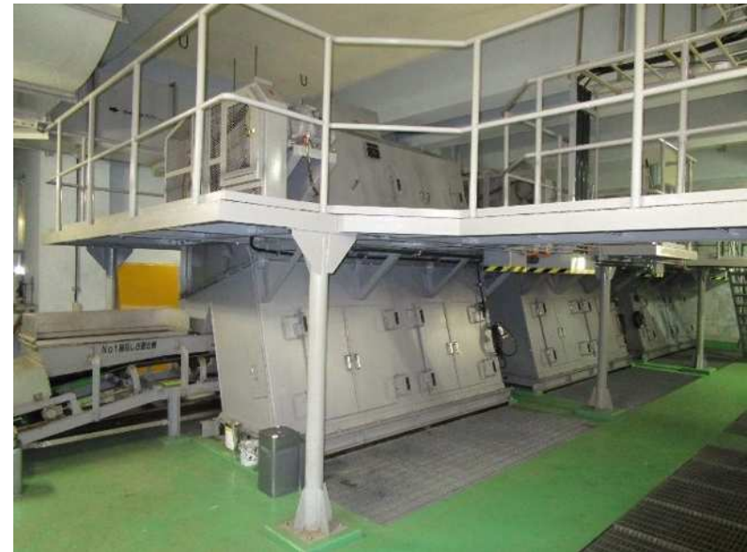
舟倉ポンプ場沈砂池機械設備更新工事
