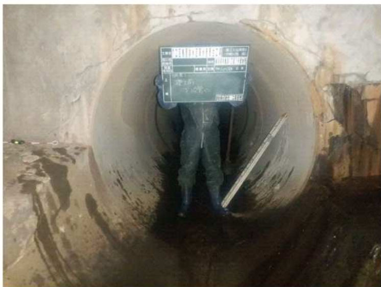
耐震化更生工事 施工前
