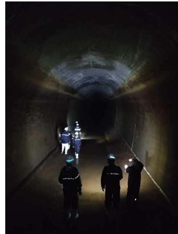
池上ずい道配水池
