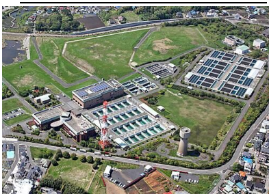
綾瀬浄水場の概要（増強整備前）
