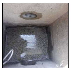
雨水ます接続部
