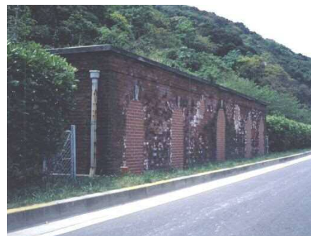
走水水源地（湧水埋渠取水施設）
