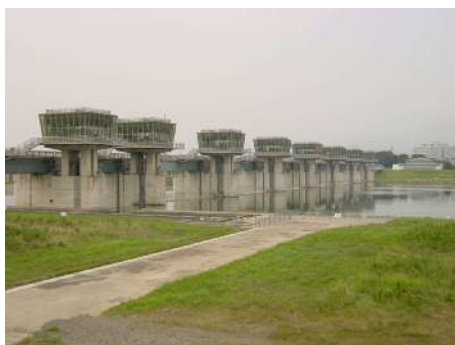
相模大堰（取水口）
