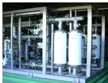
走水水源地膜ろ過設備
