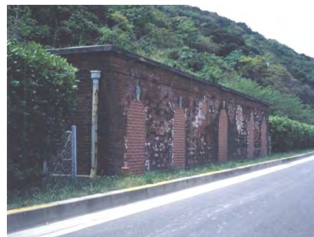
走水水源地（湧水埋渠取水施設）
