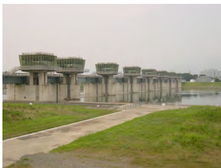
相模大堰（取水口）
