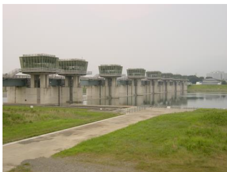
相模大堰（取水口）
