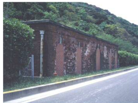
走水水源地 (湧水埋渠取水施設)
