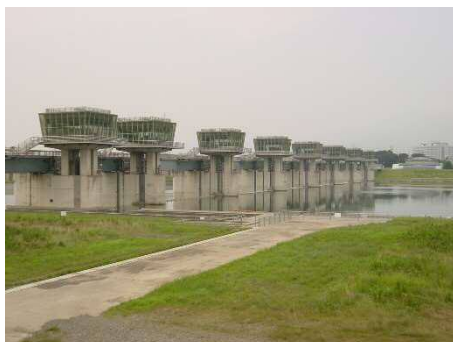
相模大堰 (取水口)
