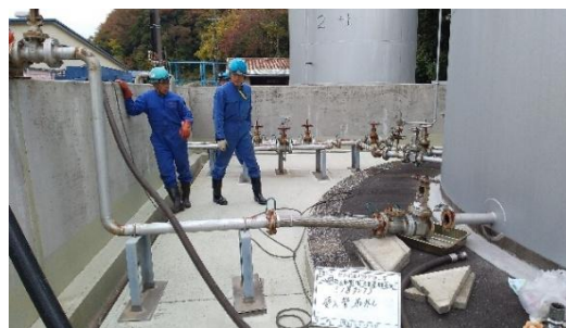
危険物施設の改修現場
