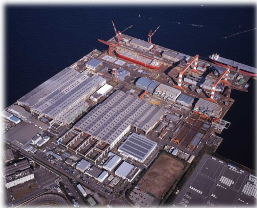
住友重機械工業株式会社 横須賀製造所 全景
