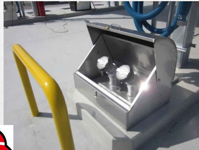
注入口ピット (遠方注入口)
