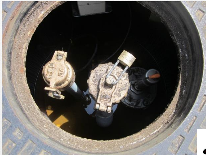
注入口 (マンホール内)
