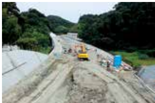
久里浜田浦線の施工状況
