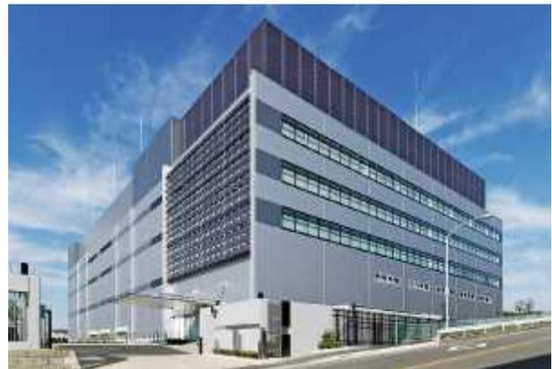
グローバルデータセンターを有しています。今回視察させていただいた富士通横浜データセンターは、横浜のアクセスに有利な場所にあり、立地としては、活断層を回避し、液状化や津波、洪水のリスクの低い場所にあります。ファシリティ設備としては、継続稼働を実現するために免震構造設計となっ
