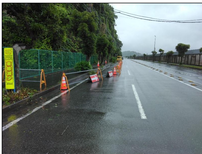
写真4 車線減少や歩行者の通行規制の状況
