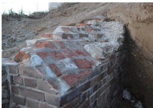
6. 隧道坑口煉瓦アーチ起点脚壁組積法
