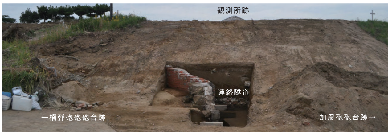
1. 榴弾砲砲台・観測所付属室及び加農砲砲台-榴弾砲砲台連絡隧道
