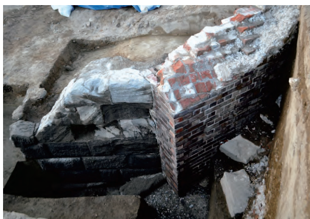
4. 加農砲砲台-榴弾砲砲台連絡隧道・煉瓦脚壁表面
