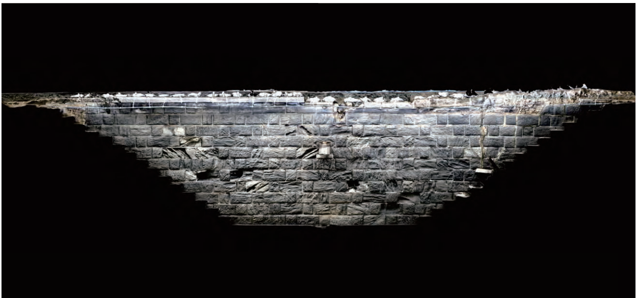
3. 加農砲砲台・南西ブラフ積被覆壁と揚弾施設
