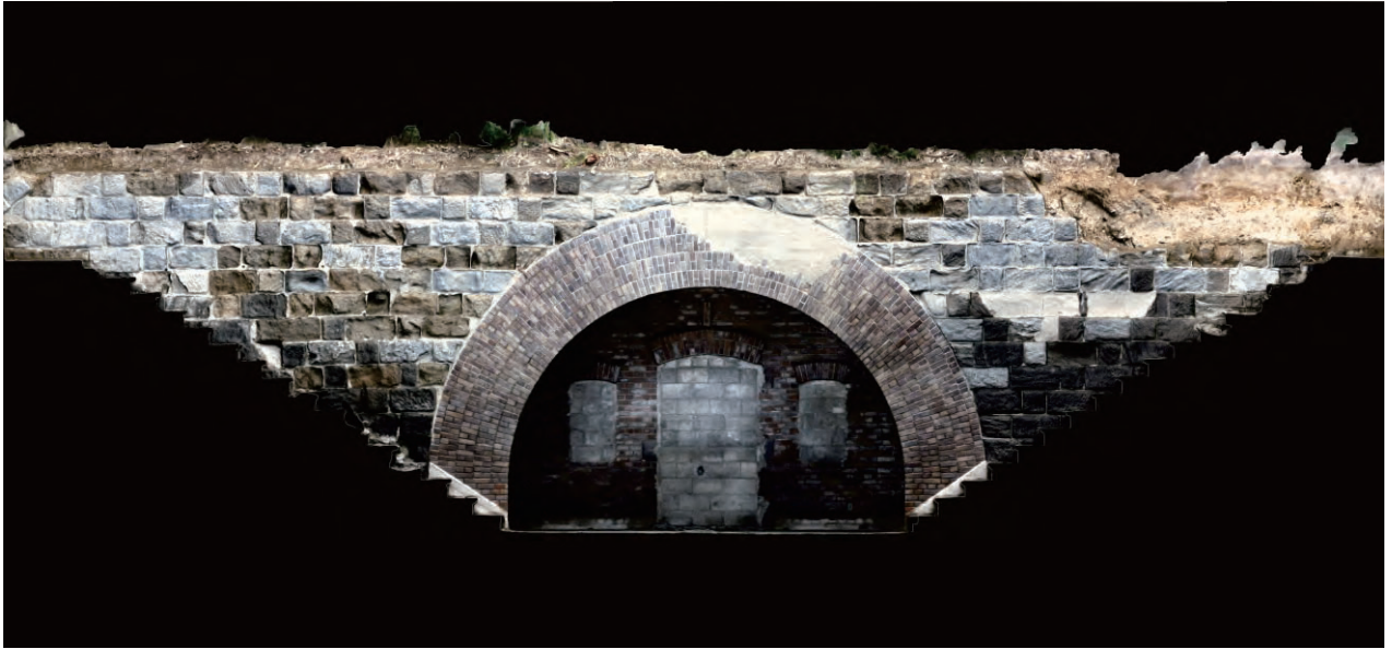
1. 加農砲砲台・砲側弾薬庫北東ブラフ積被覆壁と出入口半円アーチ
