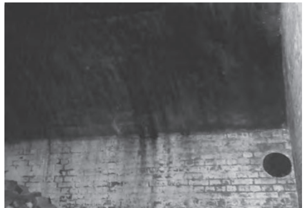
写真 2 付属室一砲座間伝声管と後面壁
