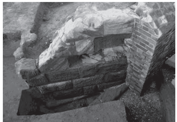
写真 2 ブラフ積被覆壁・天端石下石積
