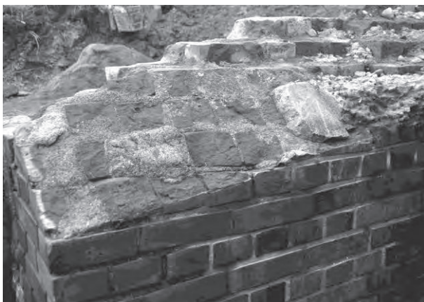
写真 1 隧道煉瓦アーチ起点
