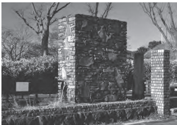
5. 砲側弾薬庫・排気筒鉄平石被覆状況（調査前）
