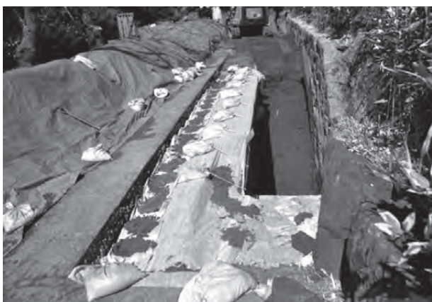
3. 加農砲砲台・砲側弾薬庫壘道天端石保護状況
