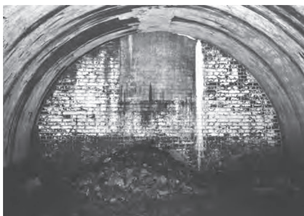
6. 砲側弾薬庫・後面壁と排気筒
