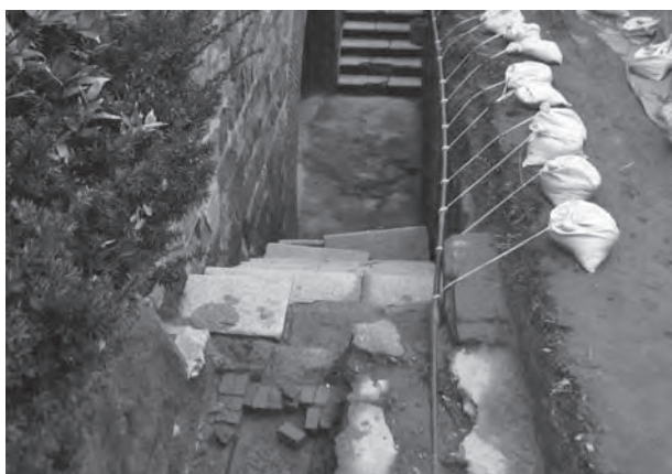
3. 加農砲砲台・砲側弾薬庫北西階段一塁道移行面
