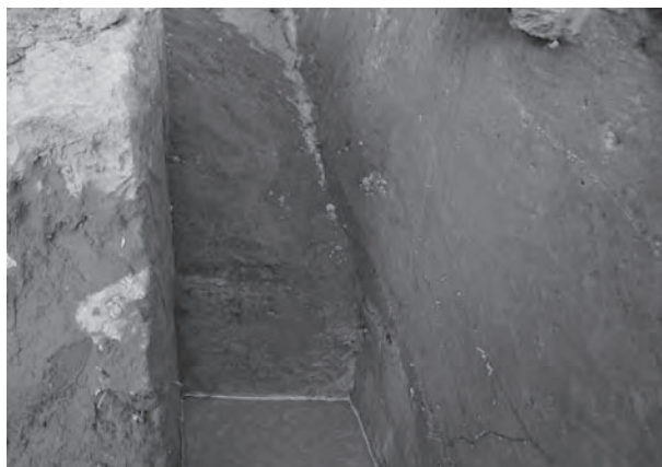
8. 加農砲砲台・乾壕外斜面
