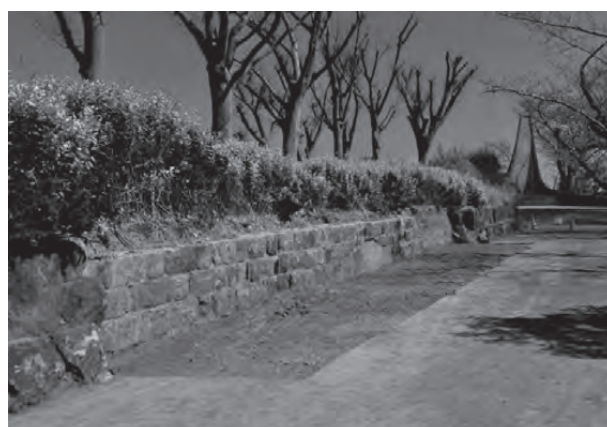
4. 加農砲砲台・砲側弾薬庫遺構面保護後の埋め戻し
