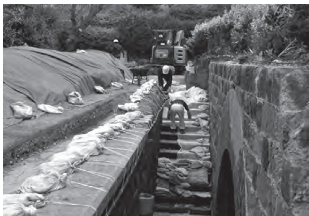
1. 加農砲砲台・砲側弾薬庫階段面保護風景
