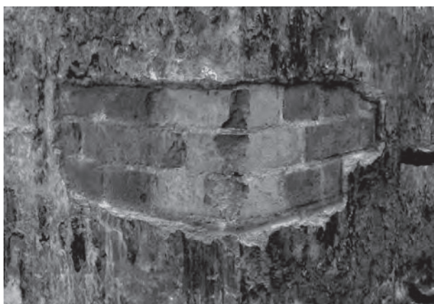
7. 加農砲砲台・排気筒（北東隅）煉瓦積組積法
