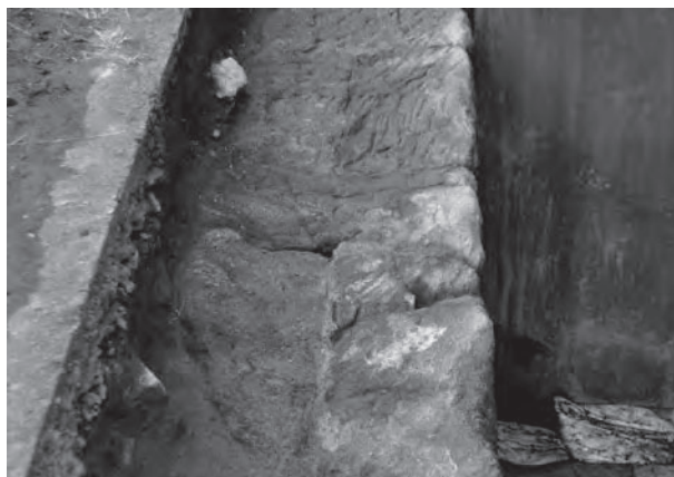
2. 加農砲砲台・棲息掩蔽部壘道被覆壁
