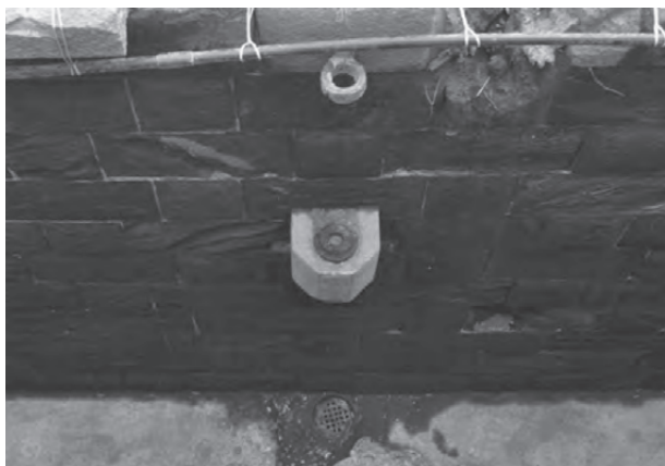
1. 加農砲砲台・砲側弾薬庫揚弾施設
