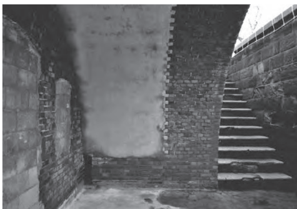
3. 砲側弾薬庫・北西階段と前面空間
