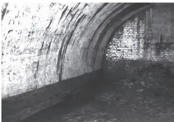
7. 砲側弾薬庫・脚壁と半円ヴォールト天井
