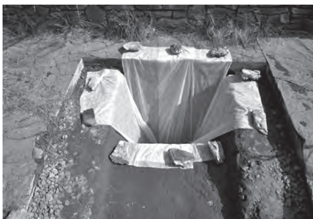
7. 加農砲砲台・乾壕内斜面保護状況
