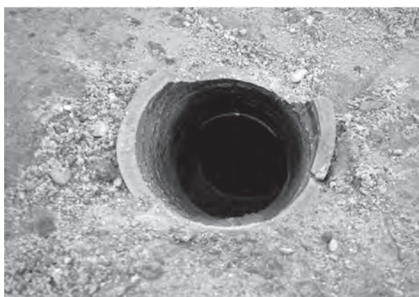
4. 榴彈砲砲台・觀測所付屬室—觀測所連絡伝声管
