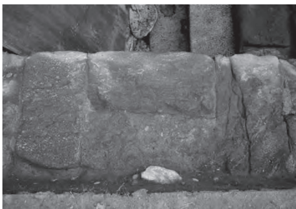
3. 加農砲砲台・棲息掩蔽部壘道被覆壁組積法
