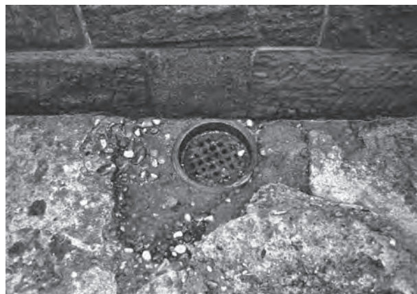
2. 加農砲砲台・砲側弾薬庫前面空間排水施設
