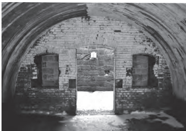
5. 砲側弾薬庫・前面壁内面と揚弾施設
