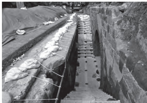
2. 加農砲砲台・砲側弾薬庫保護状況
