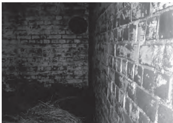
6. 榴彈砲砲台・觀測所付屬室—砲座連絡伝声管
