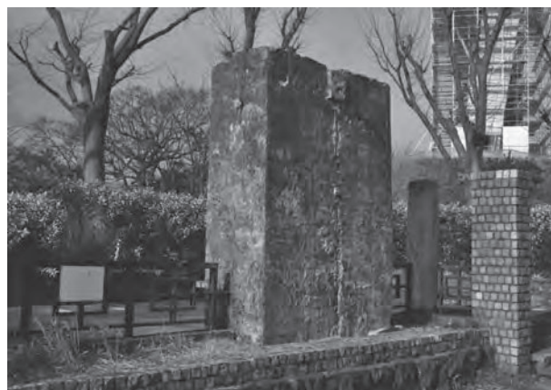
6. 加農砲砲台・排気筒鉄平石除去後の状況
