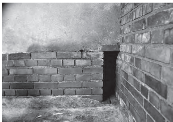
8. 砲側弾薬庫・前面壁通気孔
