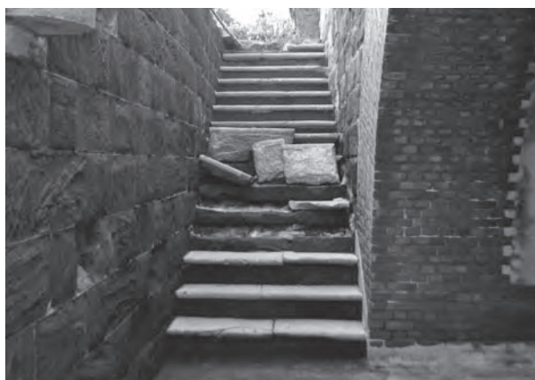
4. 砲側弾薬庫・南東階段と前面空間
