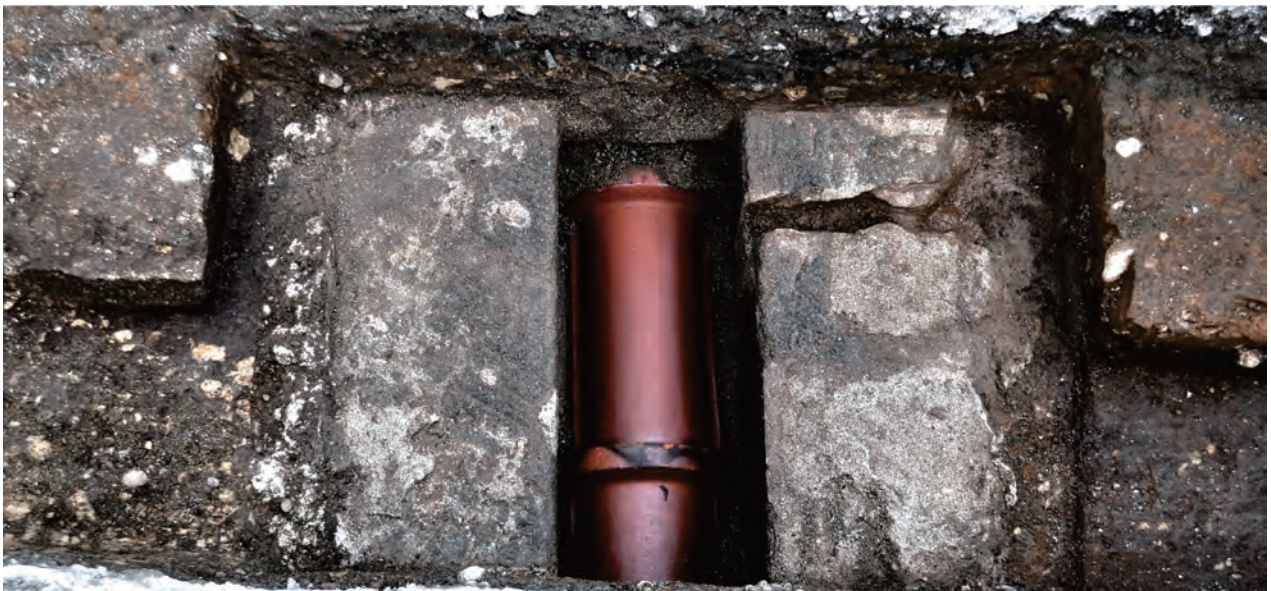
2. 試掘坑3東端検出ろ過水溝（3次調査）
