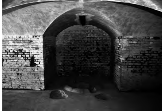
2. 西側揚弾孔と付帯施設
