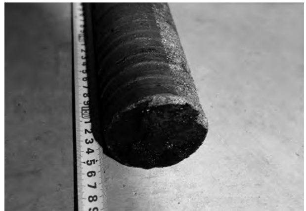
6. 第一弾薬庫煉瓦脚壁コア・背面塗布アスファルト
