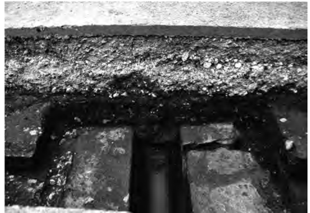
4. 3次調査試掘坑3ろ過下水溝上土層断面
