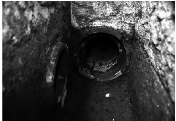
6. 集水溝内に埋設された円形土管
