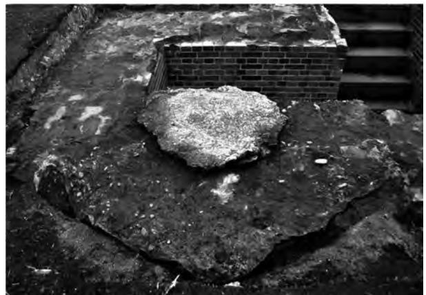
6. 地下階段外背と外背閉塞コンクリート
