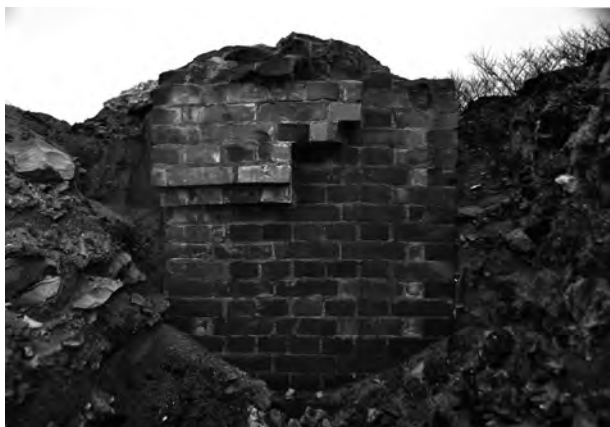
7. 伝声管敷設煉瓦構造物
