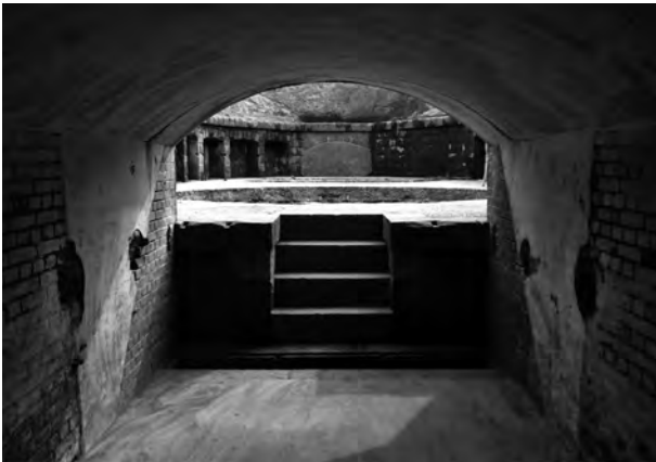
5. 高塁道一第三砲座連絡口
