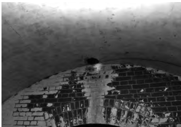
1. 左翼観測所付属室の伝声管開口部
