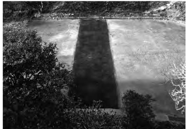
8. 3次調査試掘坑3復旧状況
