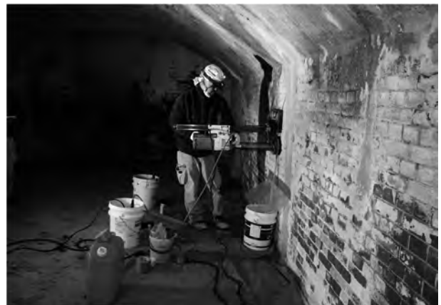
4. 第一掩蔽部右室煉瓦脚壁コア採取状況
