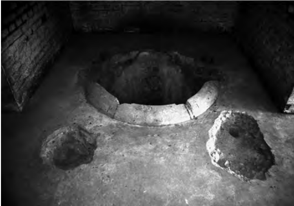
3. 揚弾孔と揚弾機設置痕・鉄材回収痕
