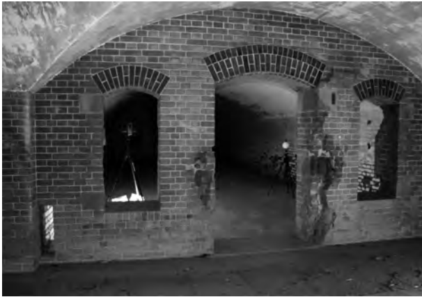
1. 3D測量調査状況
