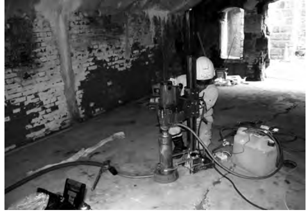
2. 第一掩蔽部右室床面コンクリートコア採取状況
