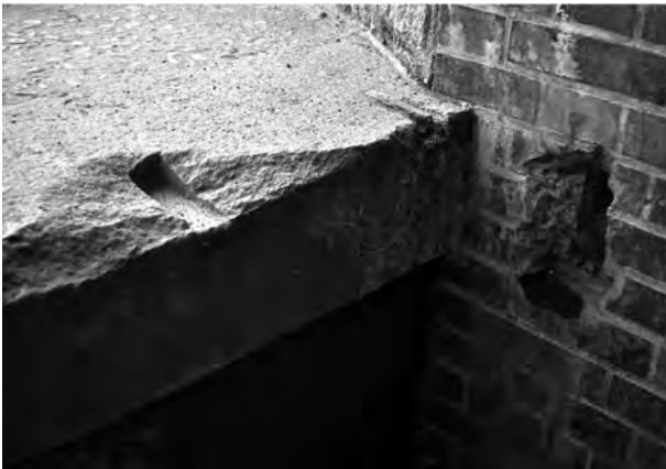
7. 角柱状鉄材装着溝と遺存する鉄材
