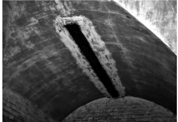
4. 天井に設置された鉄製レール
