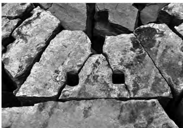
5. 砲床基礎石（内帯石）
