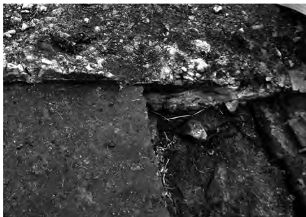
6. 基礎コンクリート型枠痕（試掘坑北西拡張区）
