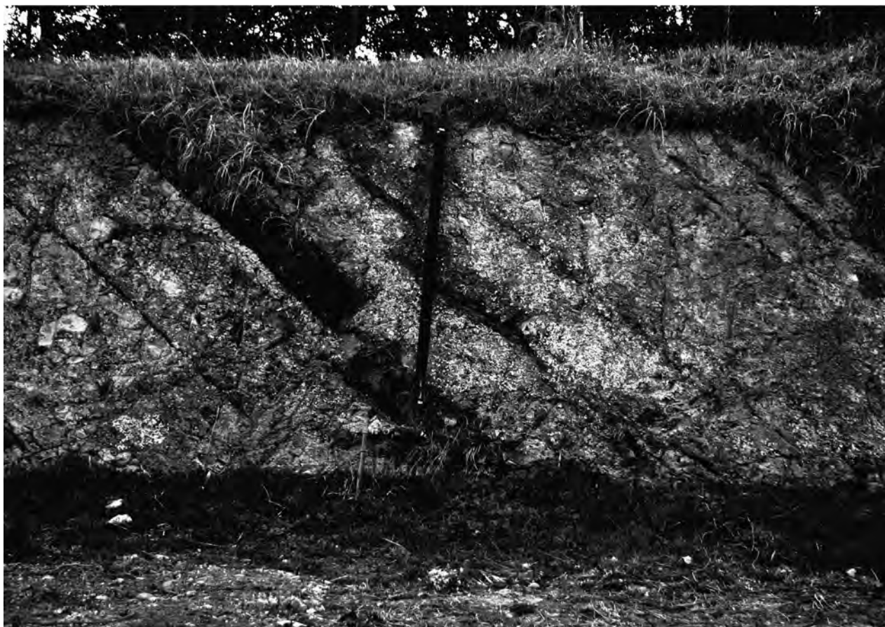
2. 千代ヶ崎通信所隊舎跡西側の削平された外周土塁
