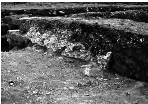
5. 基礎コンクリート型枠痕（試掘坑北西拡張区）
