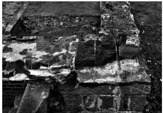
4. 粗粒凝灰岩切石と左翼観測所跡基礎コンクリート
