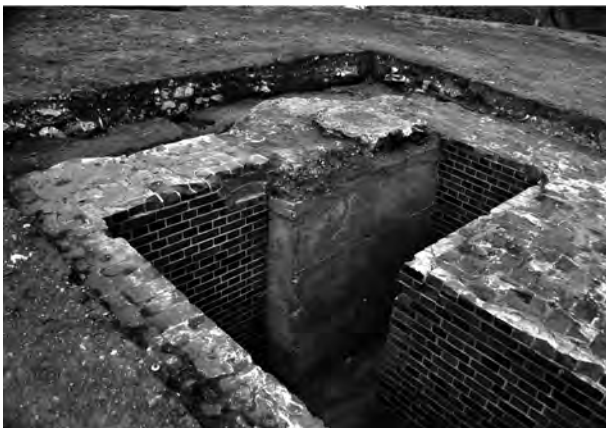
5. 地下階段－露天通路連絡口閉塞コンクリート
