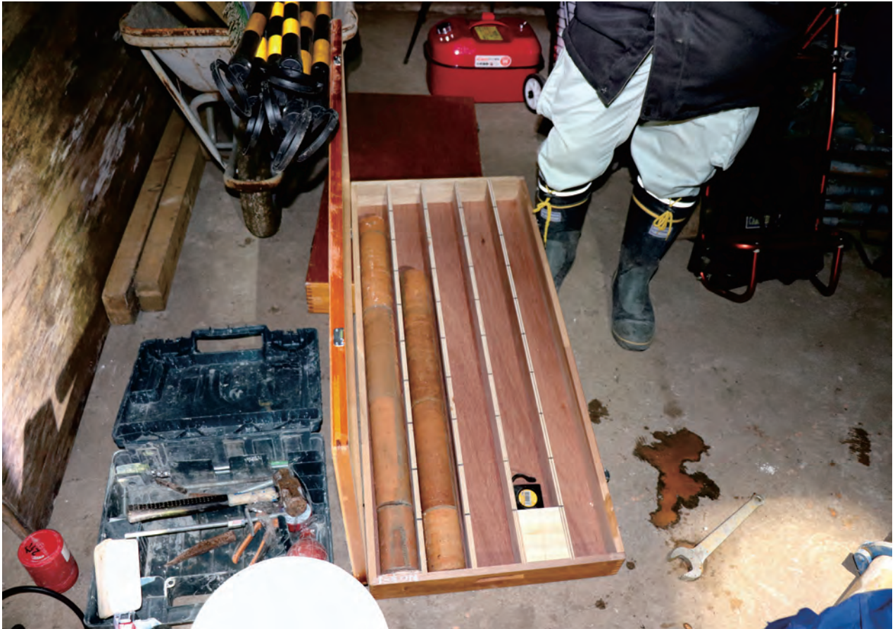
1. 現状調査（弾薬元庫脚壁コア）
