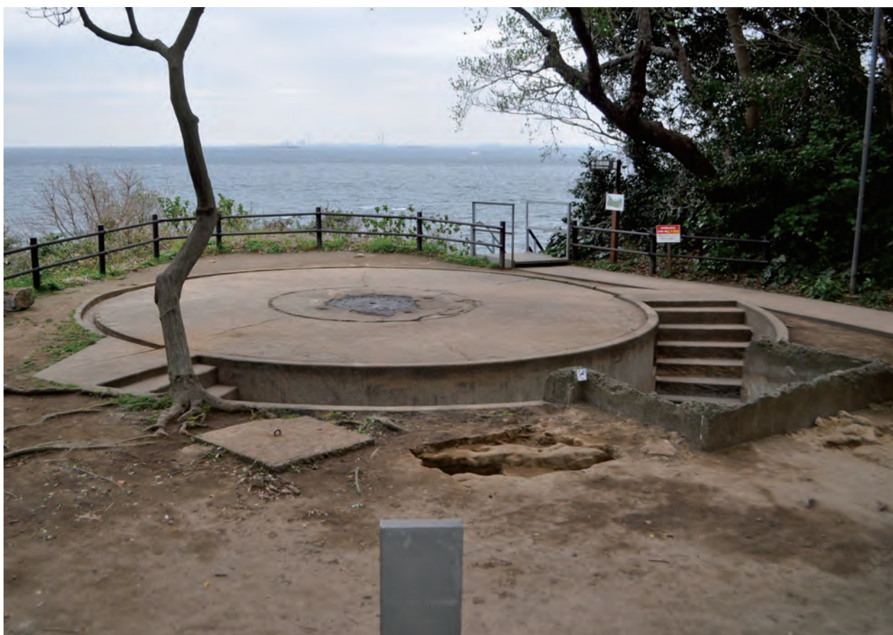
2. 猿島高角砲台跡・8 c m高角砲台第四砲座（調査後全景）
