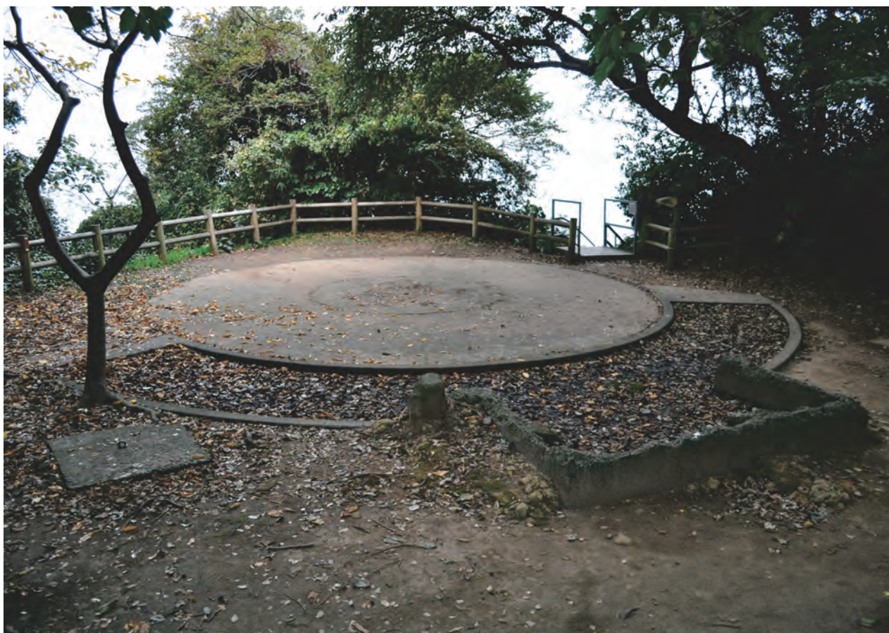
1. 猿島高角砲台跡・8 c m高角砲台第四砲座（調査前除草後）
