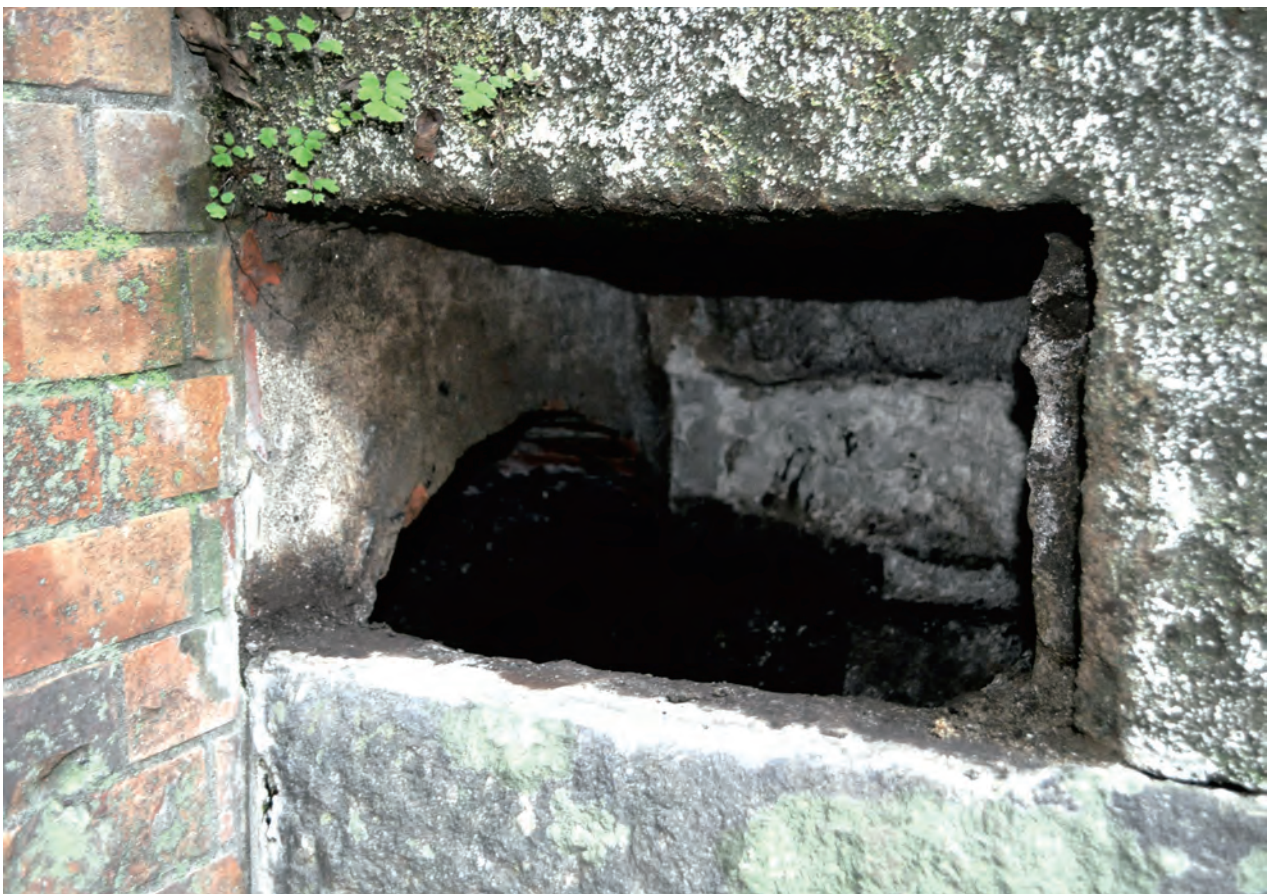
2. 現状調査 (煉瓦造小口径旧排水施設東側)
