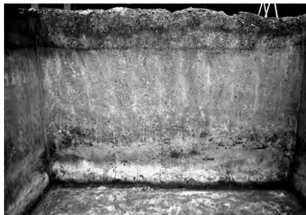
6. 砲員待機所奥壁の桢板痕
