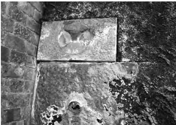
3. 現状調査・排水孔近接
