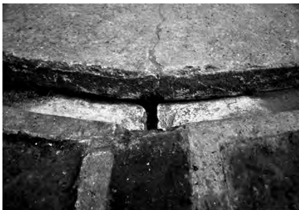
7. 低位排水溝合流部に開口する楕円形鉄管
