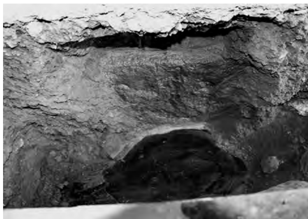
2. 第1トレンチ・アスファルト
