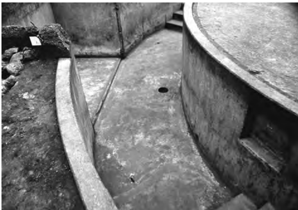
7. 砲員待機所前路面と排水口
