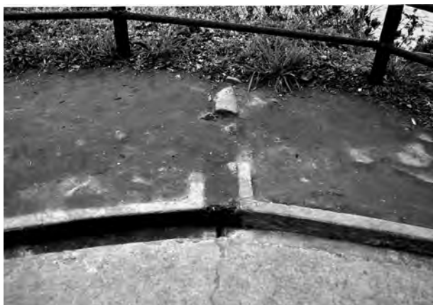
5. 低位排水溝合流部
