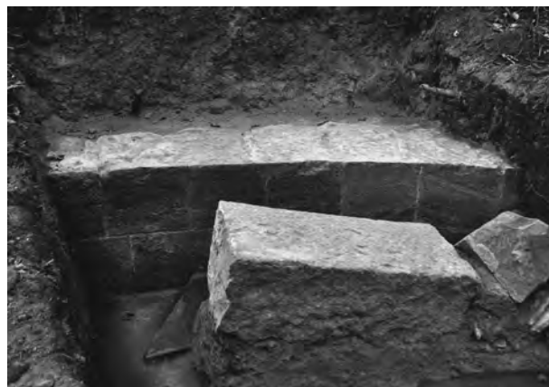
6. 試掘坑N・胸牆被覆壁と崩落した天端石
