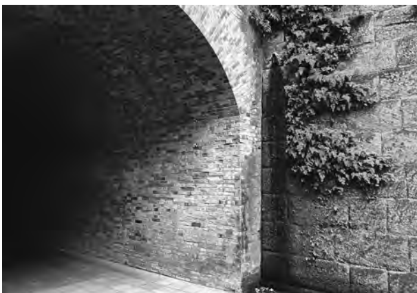
7. 現状調査・煉瓦造小口径旧排水施設右側（東側）
