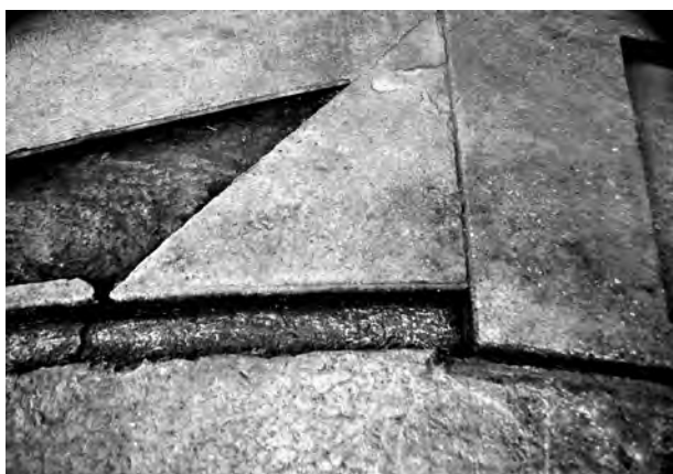
3. 高位・低位排水溝東側合流部
