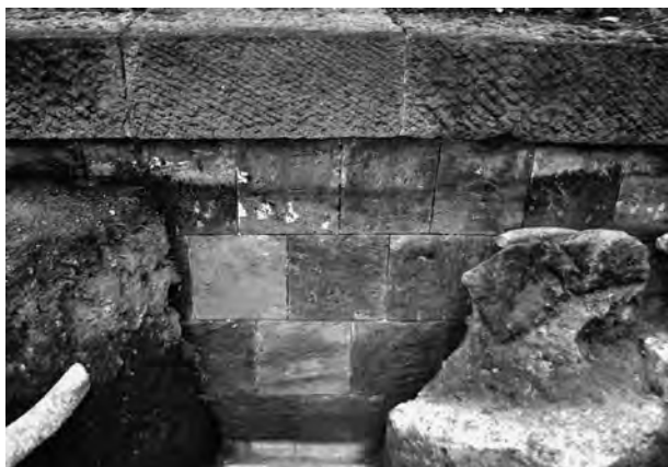
7. 試掘坑S・南東横牆被覆壁
