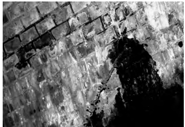
7. 現状調査・ドリル削孔No.2 湧水状況
