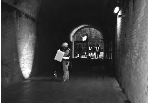
1. 現状調査・構造物点検
