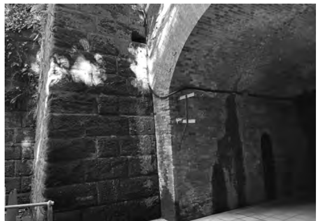
6. 現状調査・煉瓦造小口径旧排水施設左側（西側）
