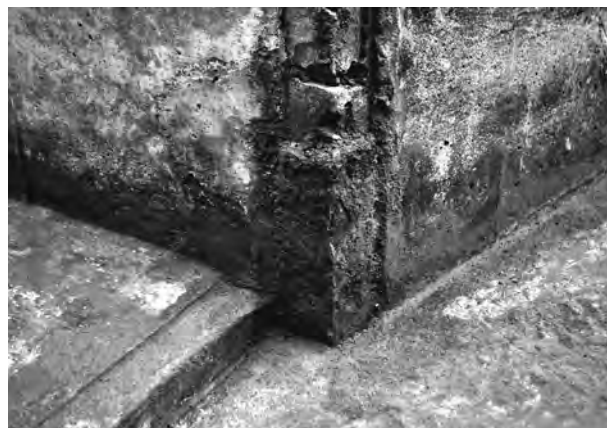
4. 砲員待機所西壁の「L」字鋼
