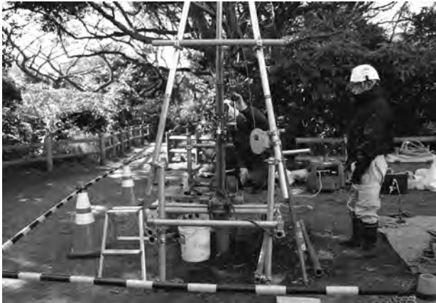
1. 現状調査・簡易コアボーリング調査状況
