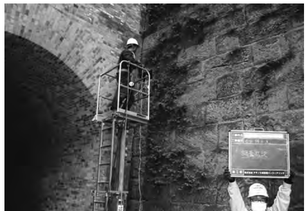
7. 現状調査・煉瓦造小口径旧排水施設調査状況
