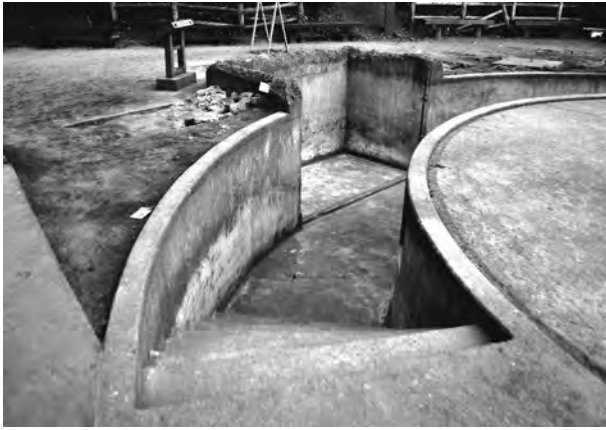
1. 砲床-砲員待機所連絡階段（東側）
