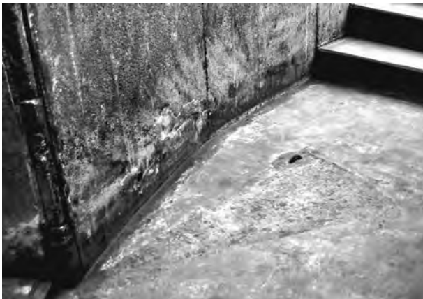
3. 西側階段下壁面円孔と「U」字金具
