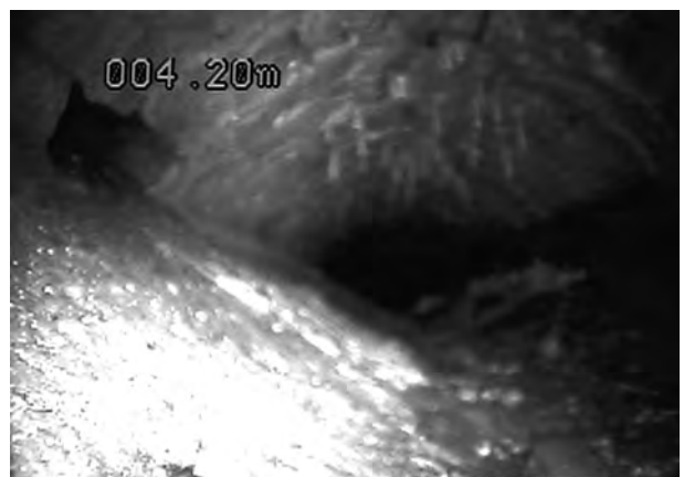
4. 現状調査・右側（東側）内部（隧道側からの排水孔）
