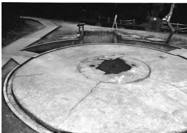
1. 8 cm高角砲台・第四砲座高位・低位排水溝
