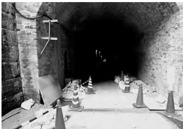
1. 隧道調査風景
