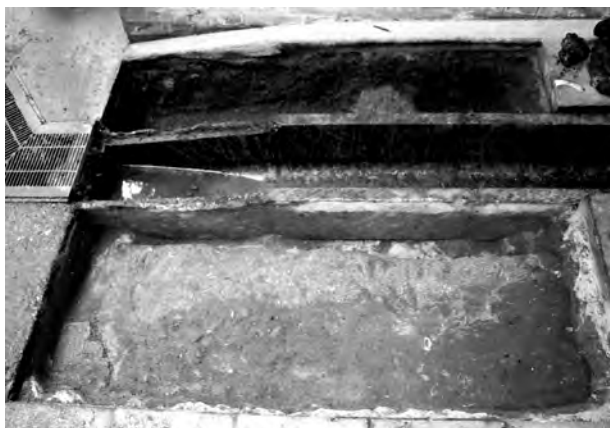
5. 第3トレンチ・モルタル敷設状況
