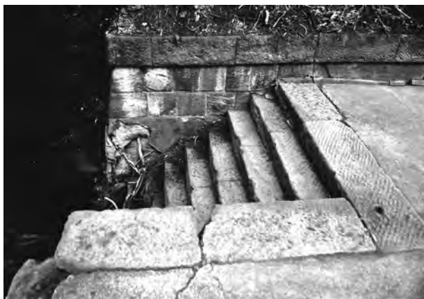
5. 第二砲座・砲座面と手摺装着痕の残る階段縁石
