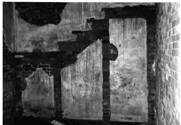
8. 吹抜室脚壁（階段痕）
