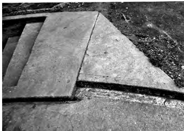
2. 高位・低位排水溝西側合流部
