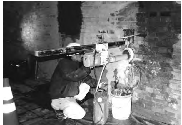
5. 現状調査・コア抜き状況
