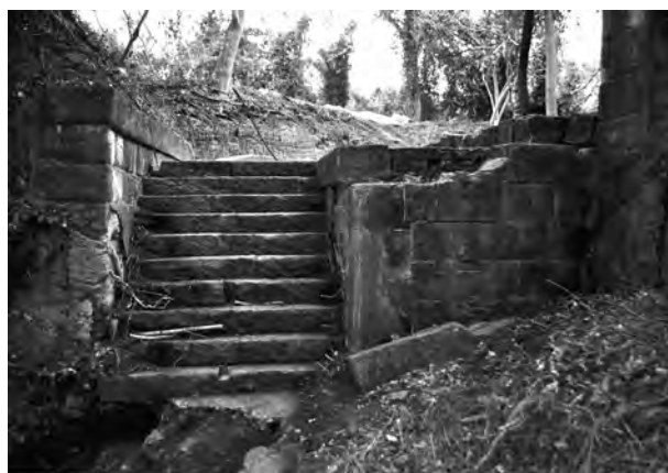
4. 第一砲台・第二砲座-高塁道連絡階段
