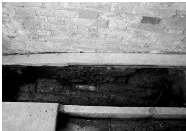
6. 第3トレンチ・煉瓦造構造物
