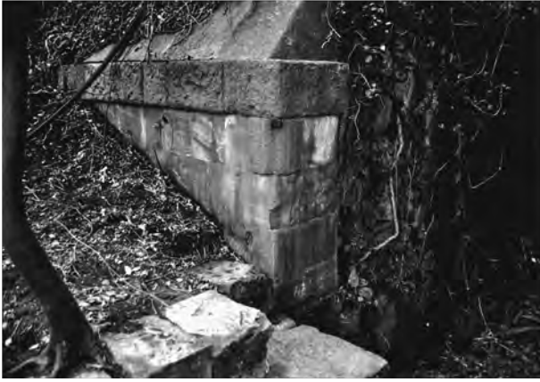
1. 高塁道-砲床間揚弾施設・高位構造体
