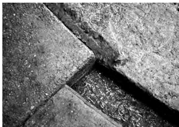
4. 高位・低位排水溝合流部の形状
