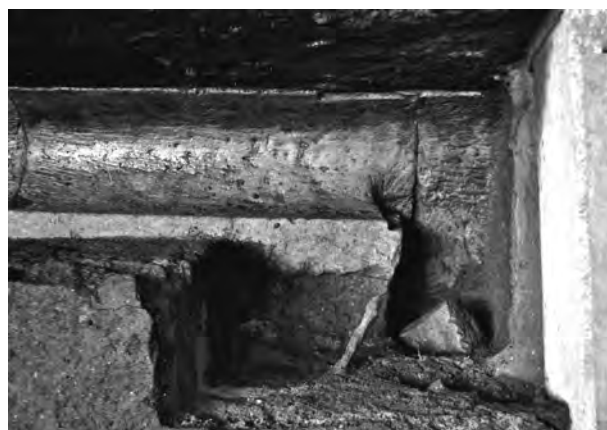
5. 第8トレンチ・隧道側端末屈曲部
