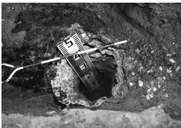
3. 第1トレンチ・コンクリート穿孔
