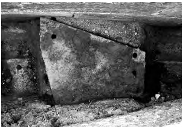
7. 試掘坑N・円孔のある鉄板2
