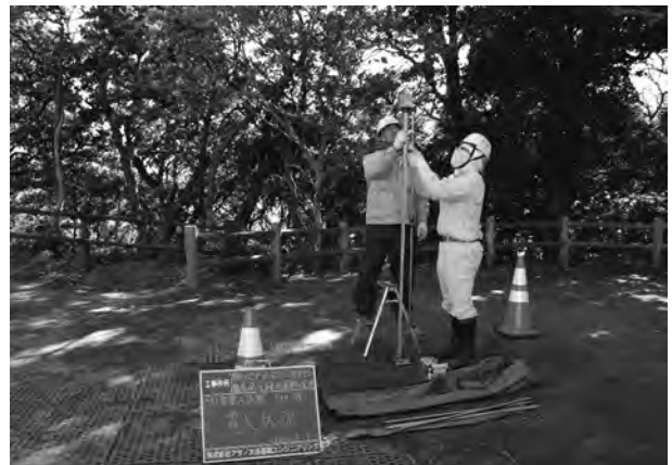
4. 現状調査・SH貫入試験状況
