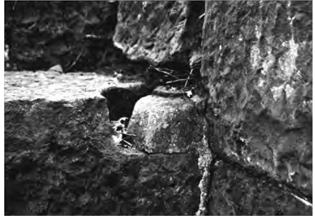
4. 高位構造体・軸受金具付施設
