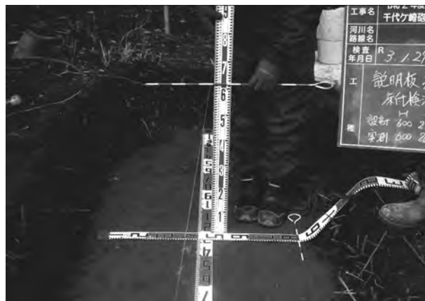
2. 説明施設（総合説明板基礎掘削状況）
