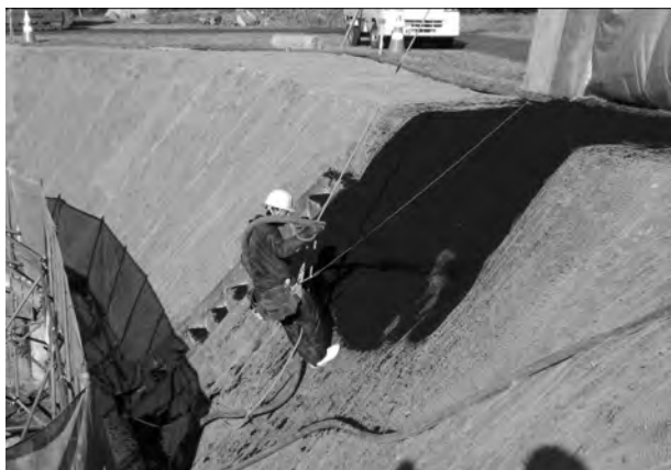
5. 法面保護工（砲座法面植生基材吹付状況）
