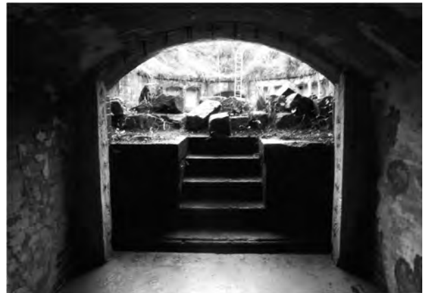
6. 撤去工 (高塁道閉塞コンクリート壁 4)
