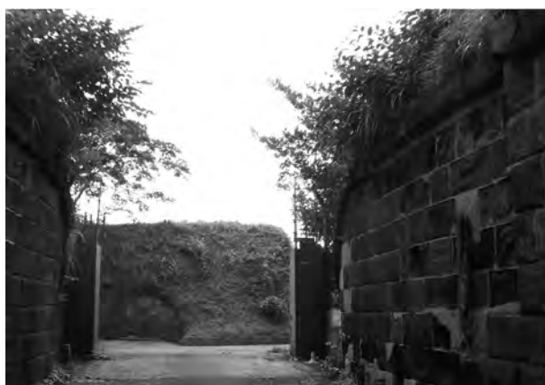
6. 電気工事(電柱撤去後)
