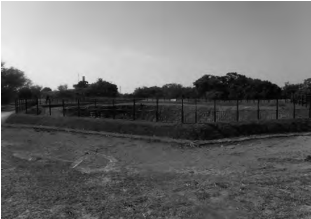
3. 管理施設 (砲座侵入防止柵)
