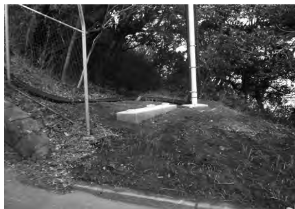
3. 説明施設（総合説明板基礎打設）
