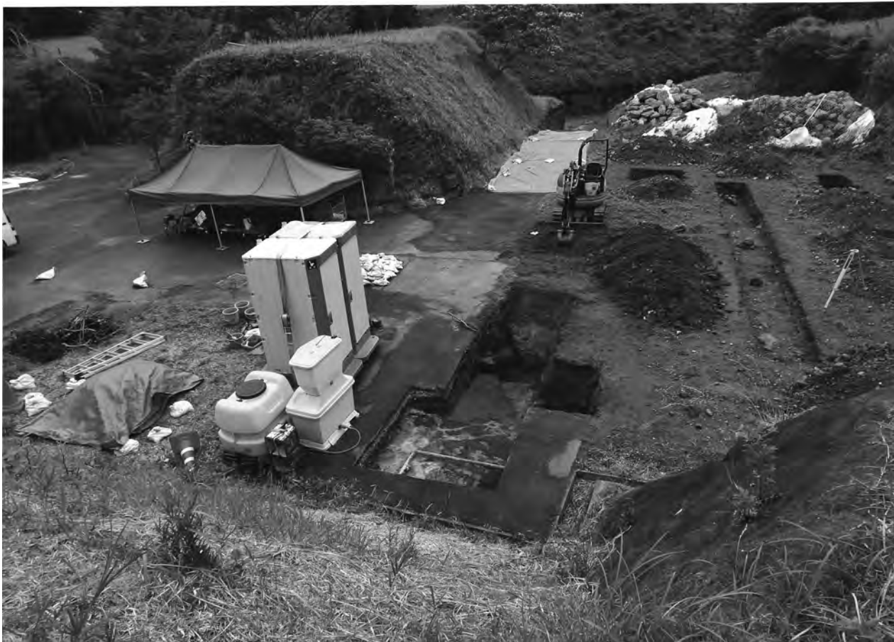
1. 5次調査A地点完掘状況（北から）
