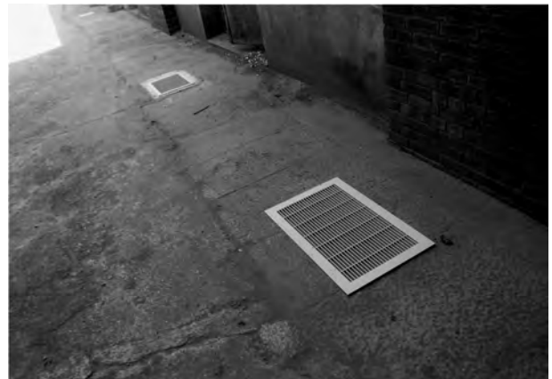
8. 管理施設 (側溝蓋欠損部整備後)
