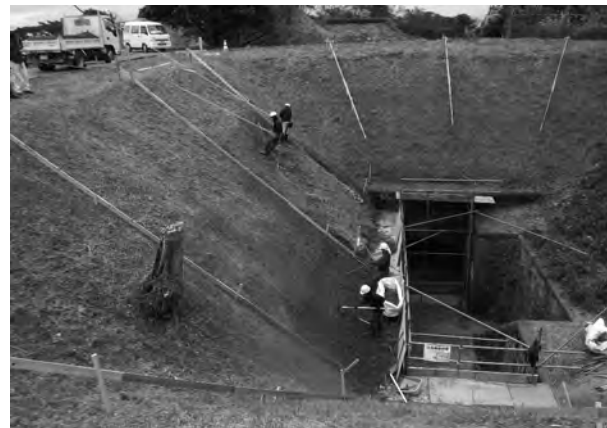
6. 法面保護工（露天空間流出土除去状況）
