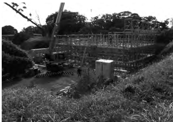
4. 便益施設(建設の様子)
