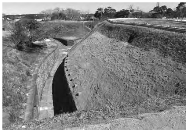
4. 法面保護工（露天空間法面流出土除去後）
