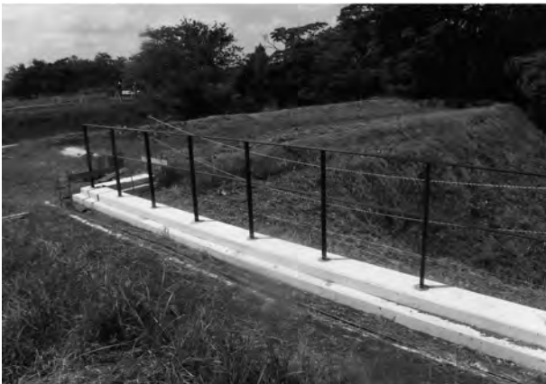
7. 雨水流入防止工（侵入防止柵設置）
