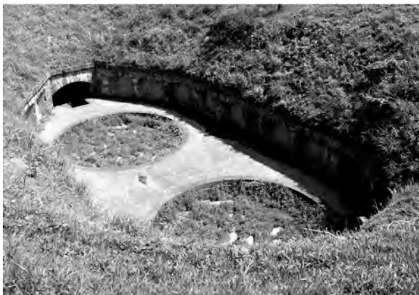
4. 樹木伐採前（第一砲座法面）
