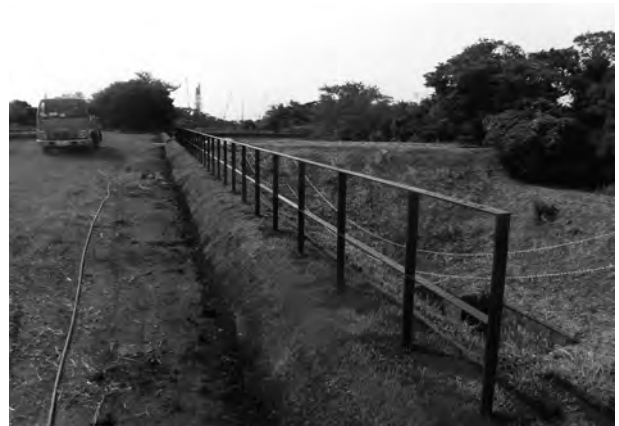
8. 雨水流入防止工（基礎盛土・張芝）
