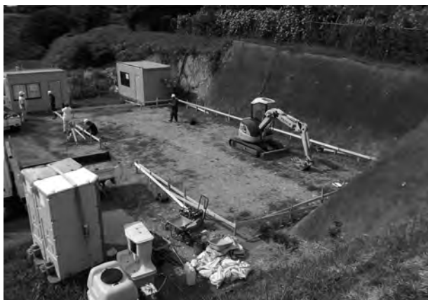
1. 便益施設(工事前)
