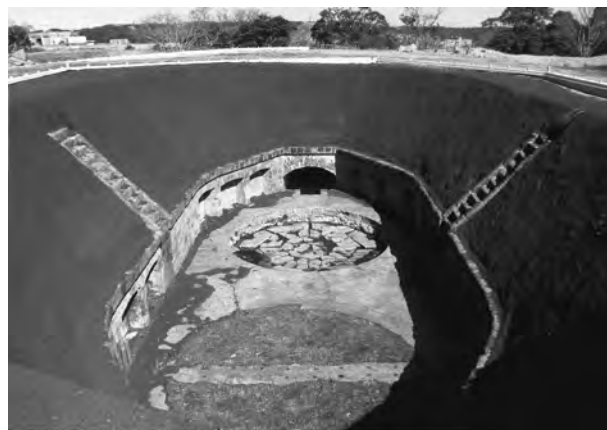
2. 法面保護工（砲座法面植生基材吹付後）
