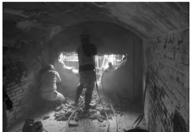
4. 撤去工 (高塁道閉塞コンクリート壁 2)
