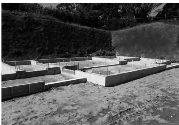
3. 便益施設(基礎工事 2)
