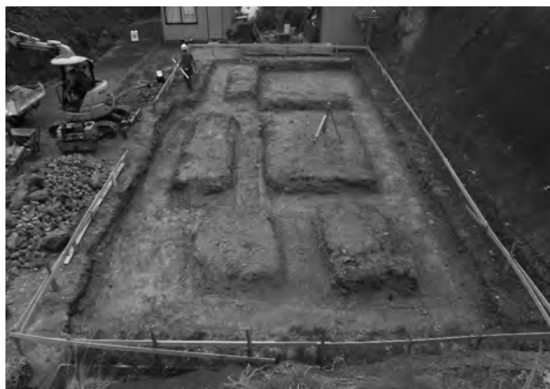
2. 便益施設(基礎工事 1)
