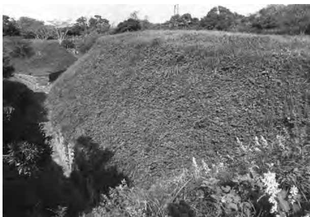
3. 法面保護工（露天空間法面流出土除去前）
