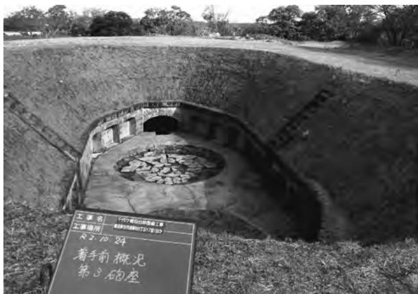
1. 法面保護工（砲座法面植生基材吹付前）
