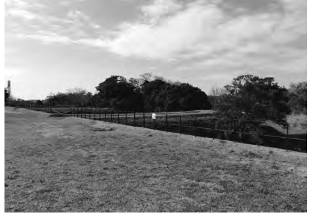
4. 管理施設 (露天空間侵入防止柵)
