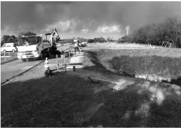
5. 雨水流入防止工（碎石敷設）
