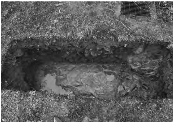
3. 試掘坑2完掘状況(東から)
