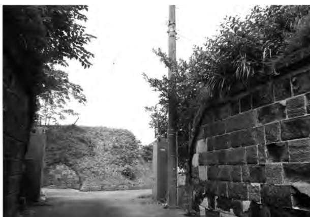
5. 電気工事(電柱撤去前)
