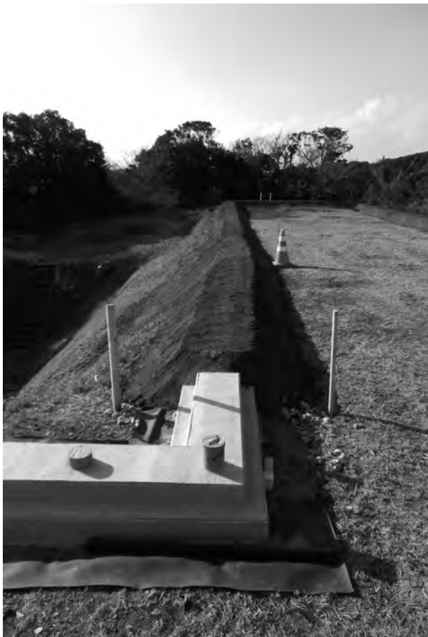
1. 雨水流入防止工（舌状張り出し部）
