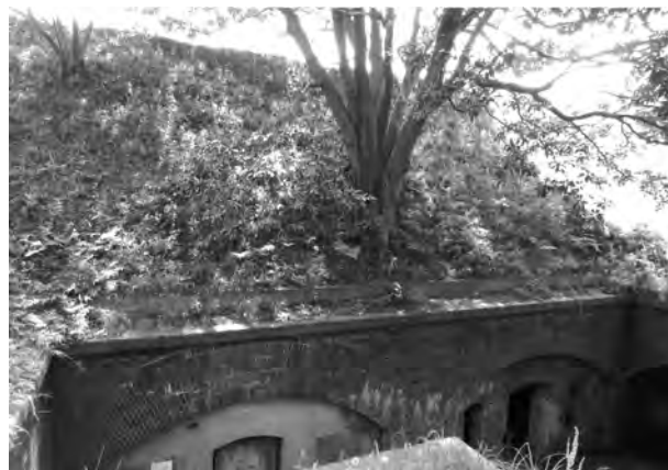
6. 樹木伐採前（第二露天空間）
