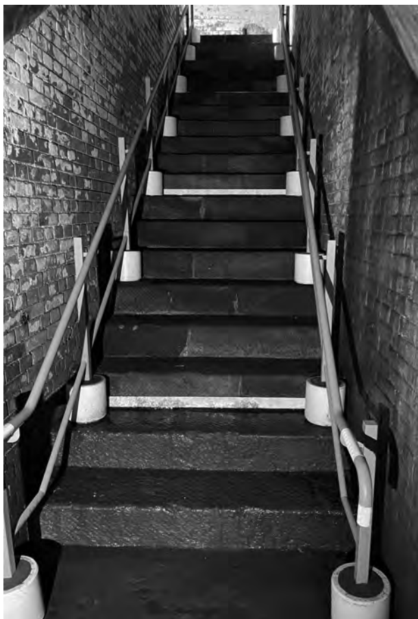
1. 管理施設（交通路階段手すり）
