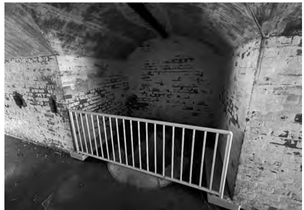
6. 管理施設 (揚弾井侵入防止柵)
