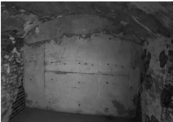
3. 撤去工 (高塁道閉塞コンクリート壁 1)
