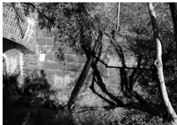
3. 雨水流入防止工（第一貯水所への導水）
