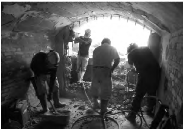
5. 撤去工 (高塁道閉塞コンクリート壁 3)
