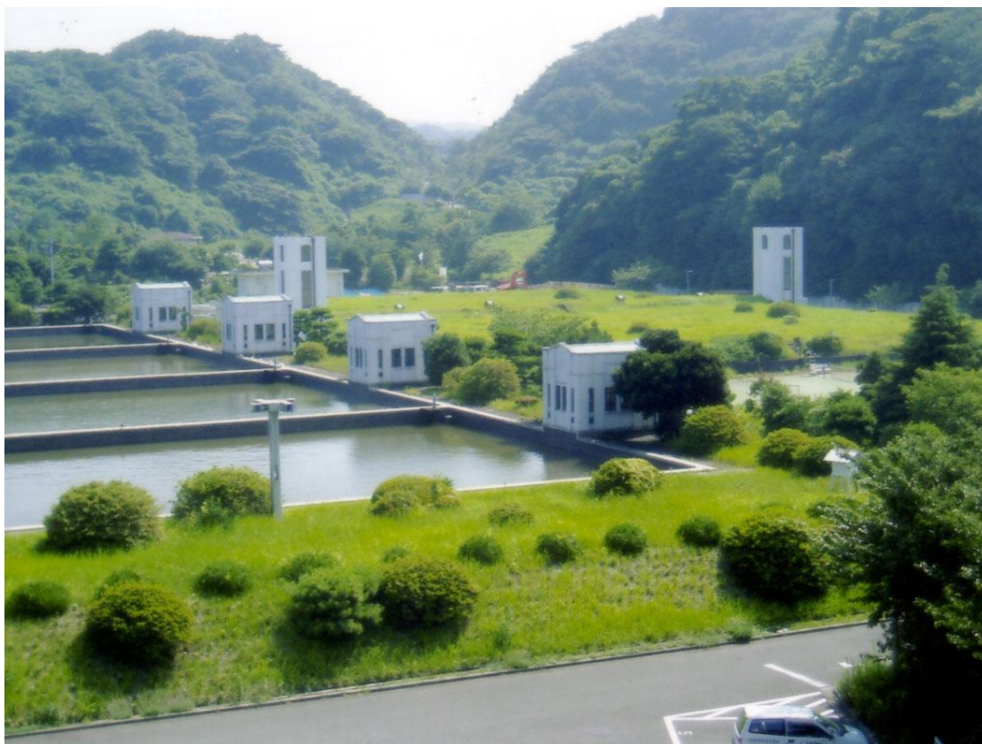
写真 1 : 緩速ろ過池・配水池周辺（調整室 4 棟・配水池東西入口）
