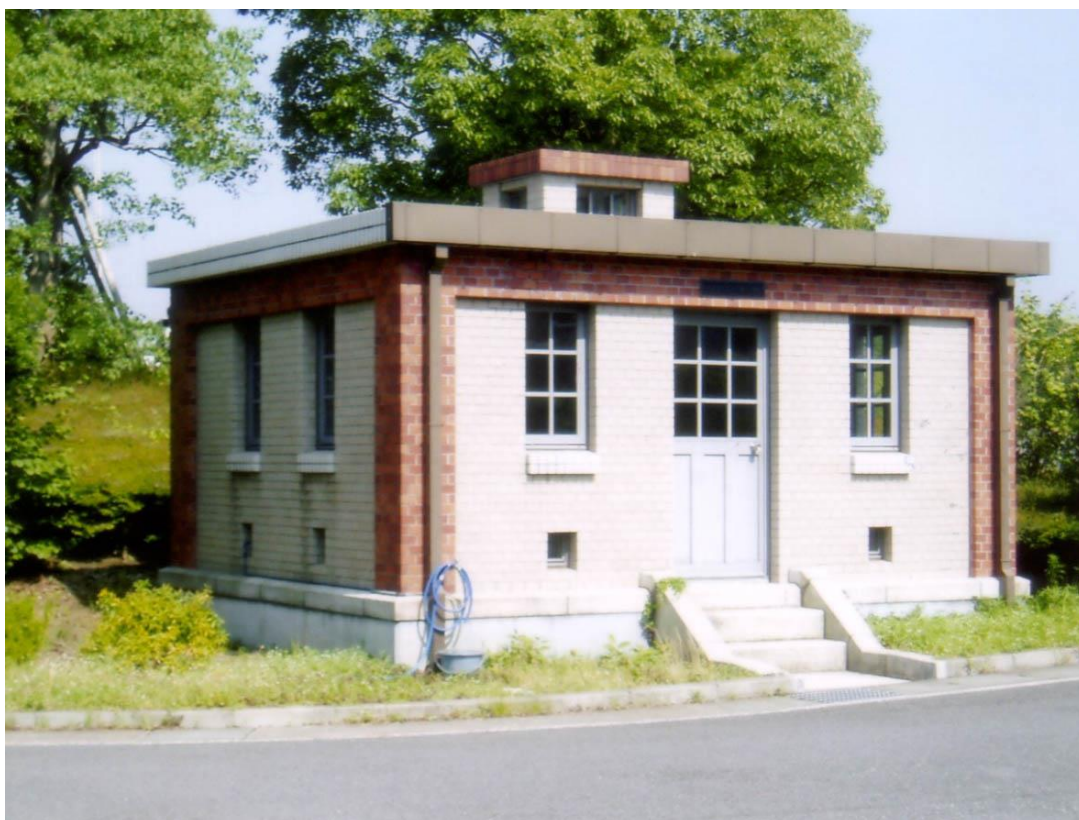
写真 4 : ベンチュリーメーター室
