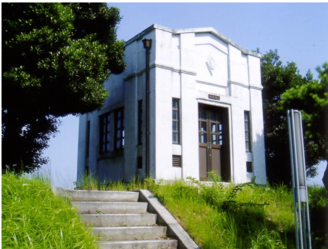
写真 2 : 緩速ろ過池調整室
