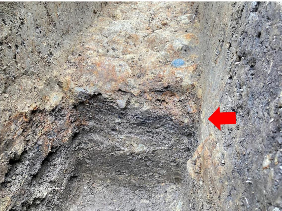
4.地業（造成）面の断面 TP3～4の間。泥岩礫の厚さ20～30cm。その下も互層に造成されている。
