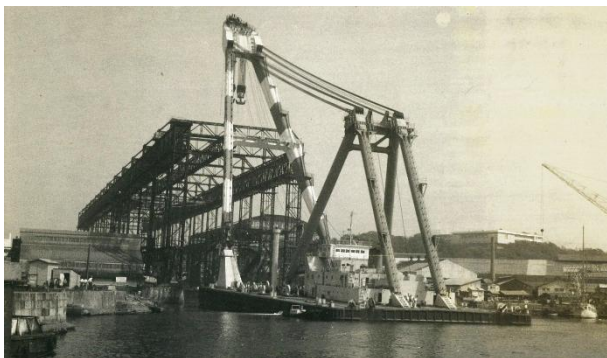
1974.8.7 解体工事中のガントリークレーン
