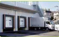
コンテナを配送車に積み込む時には、搬出口と配送トラックの荷台を密着させるドックシェルターという装置を使い、外気やほこりなどが入らないようにします。
