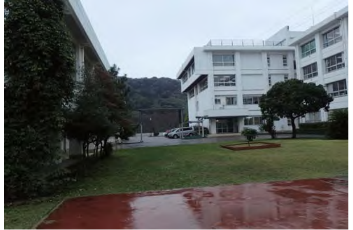
アプローチ（搬入通路）
