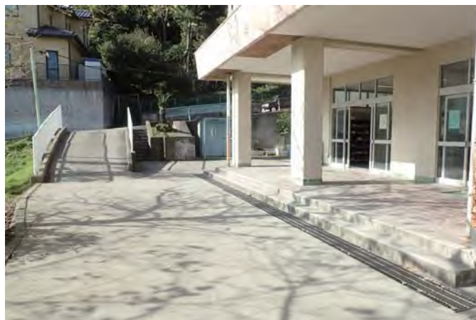
校地南側通路～西側通路（搬入経路）
