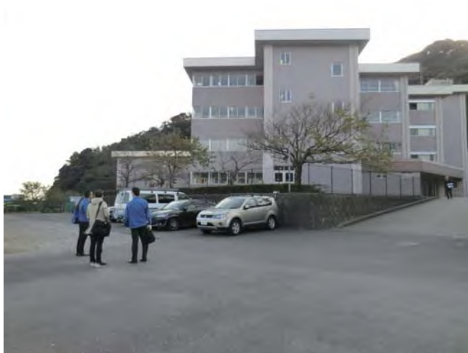
校地内通路と駐車スペース（搬入経路・給食室候補場所）
