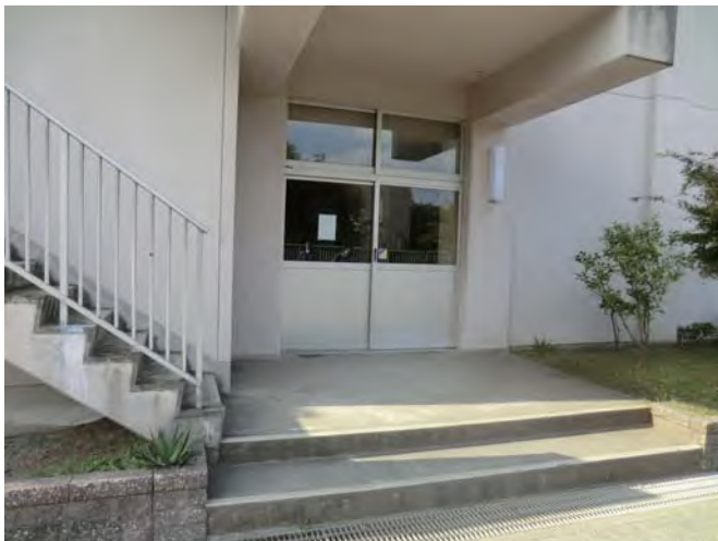
校舎入口（運搬経路）
