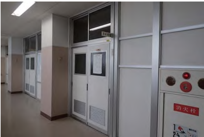
廊下（エレベーター想定場所）
