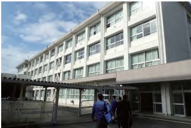
校舎入口（運搬経路）
