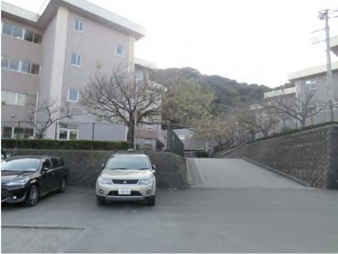
校地内通路（運搬経路）
