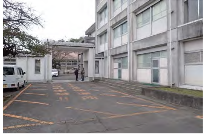
桜台棟南側（着梯あり）
