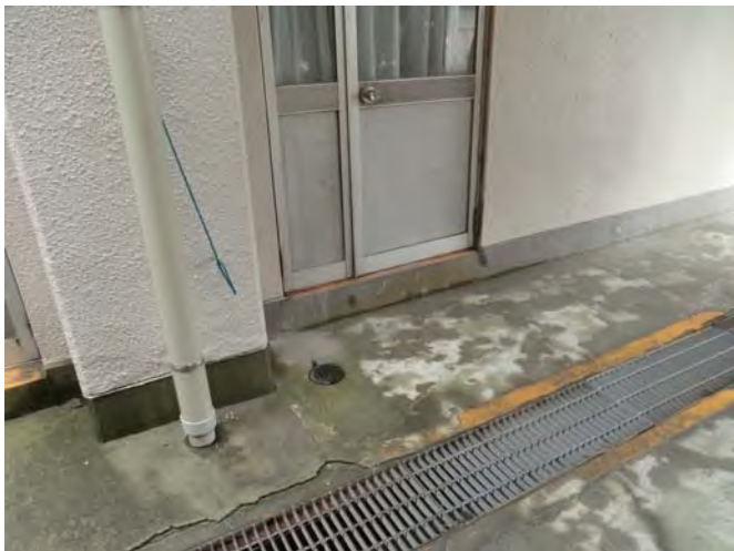
校舎南棟入口（運搬経路）
