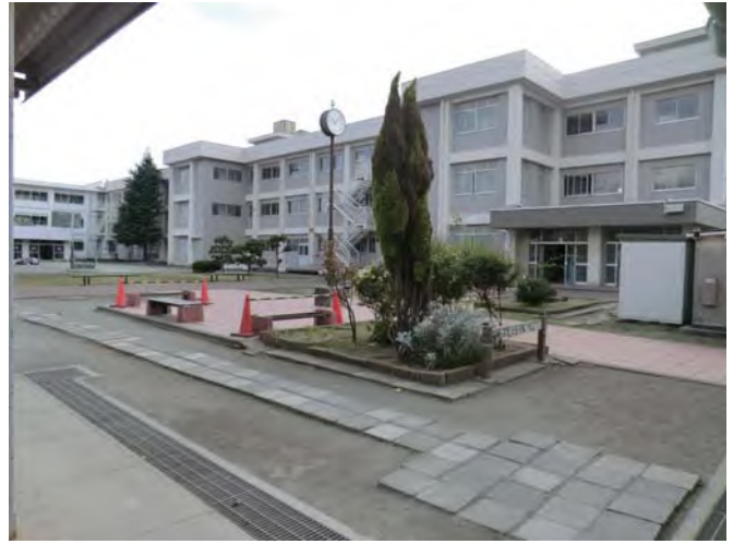
校舎B棟北側
