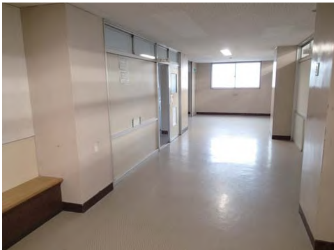
3階教室前廊下（エレベーター想定場所・運搬経路）
