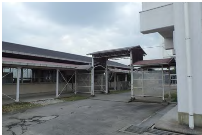
技術室棟（給食室候補場所）
