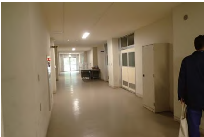
格技室棟1階廊下（エレベーター想定場所）
