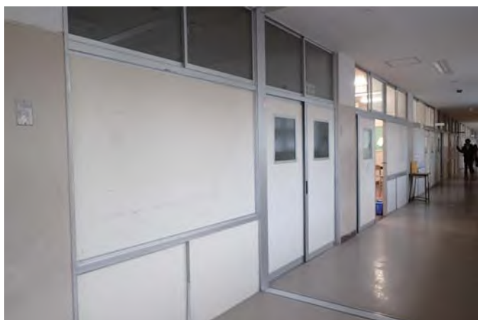
A棟廊下（エレベーター想定場所）
