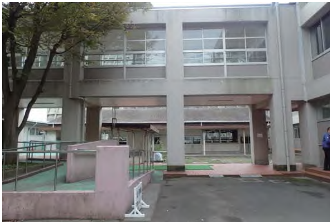
アプローチ（搬入通路）
