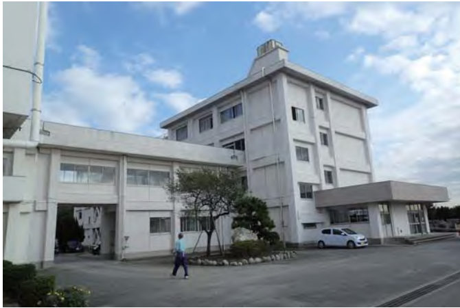
中庭入口（搬入経路）
