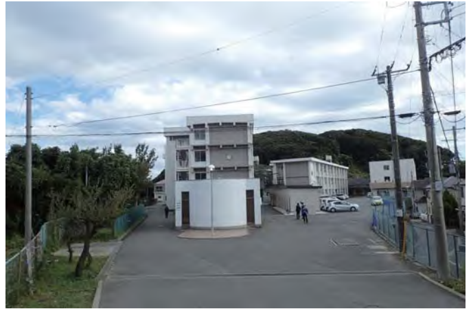
アプローチ（搬入通路）
