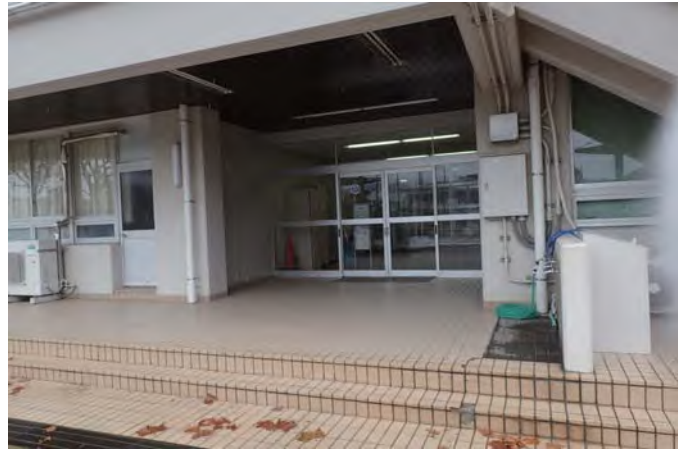
昇降口（運搬経路）
