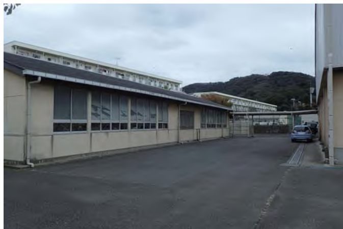
技術室棟（給食室候補場所）
