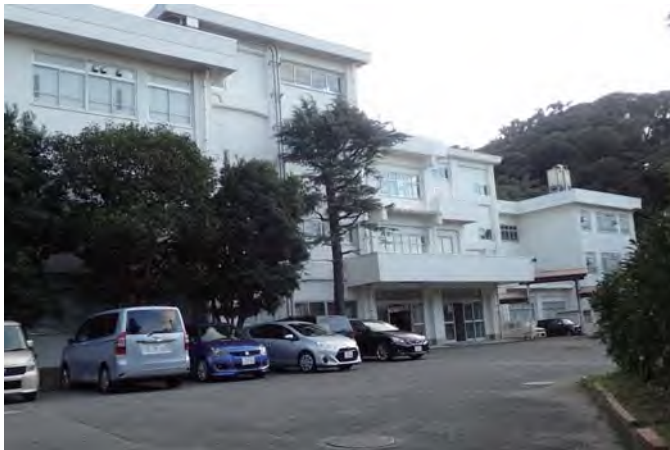
アプローチ（搬入通路）
