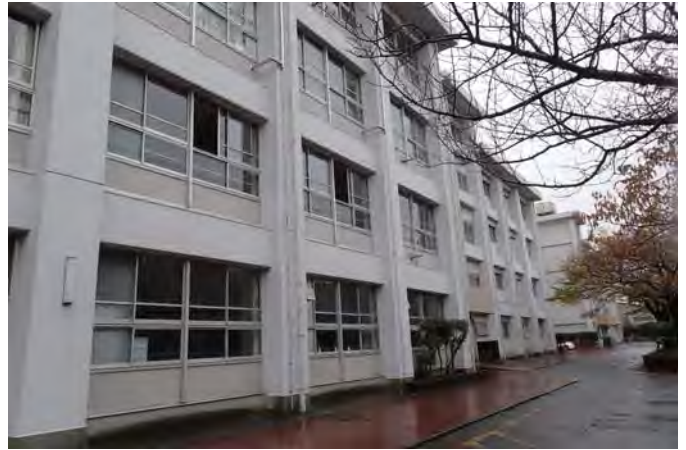
校舎南側（着梯あり）
