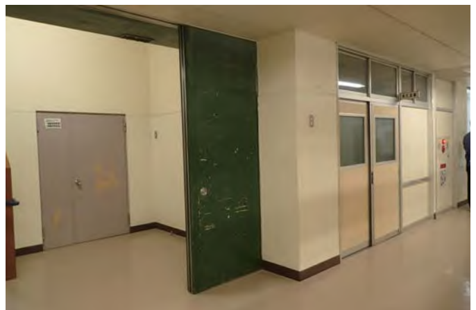
倉庫（エレベーター想定場所）
