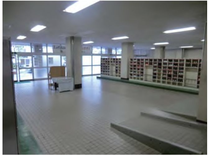
校舎北側玄関内部（搬入経路）
