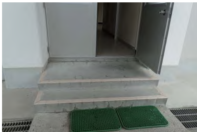
校舎入口（運搬通路）
