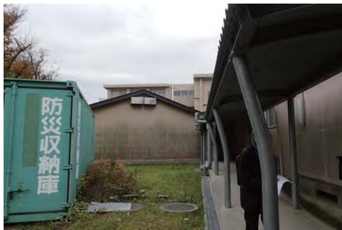
技術室棟（給食室候補場所）北側
