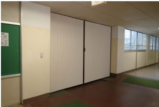
1階ホール（エレベーター想定場所）
