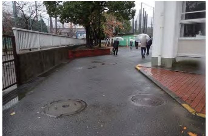
敷地内通路（搬入通路）
