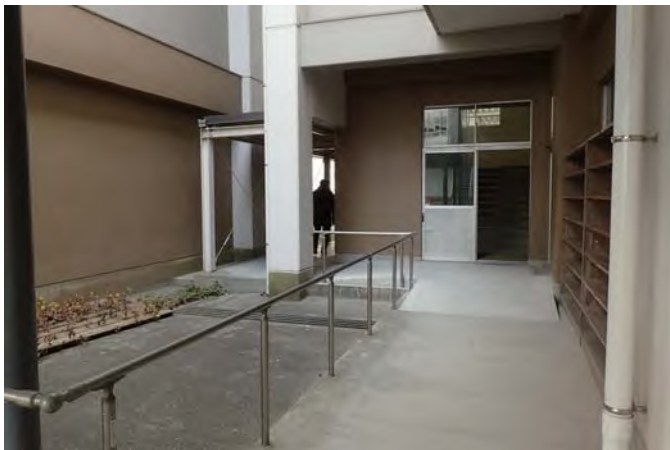
校舎入口（運搬通路）
