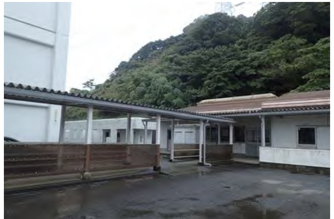
技術室棟・通路
