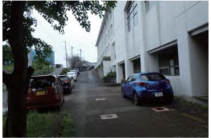
格技室棟1階（搬入口）
