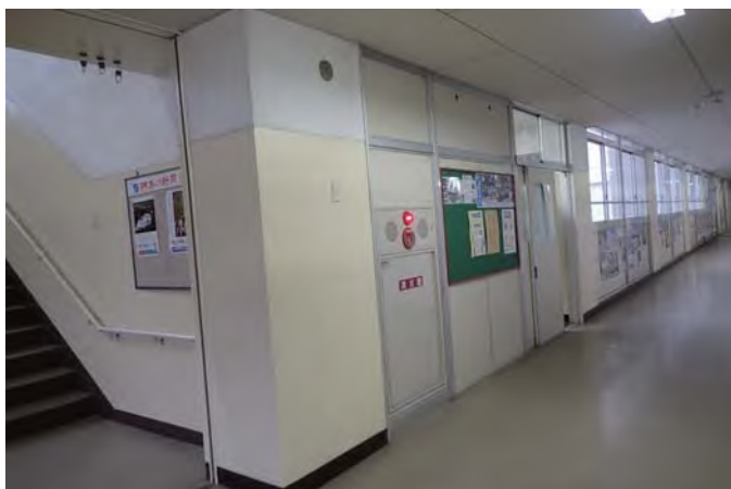
廊下（エレベーター想定場所）
