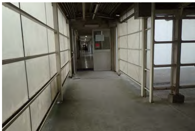
A棟校舎入口（運搬通路）
