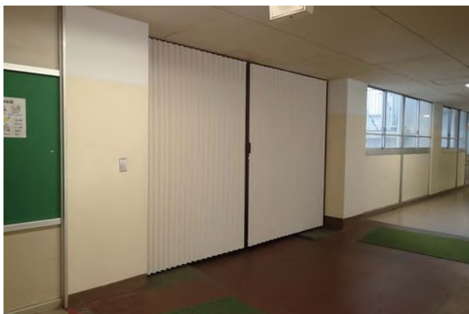
1階ホール（エレベーター想定場所）
