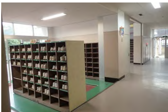
北側昇降口（エレベーター想定場所）
