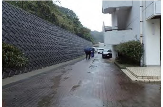
アプローチ（搬入通路）
