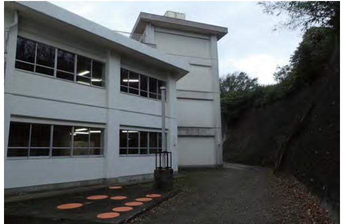
アプローチ（搬入通路）
