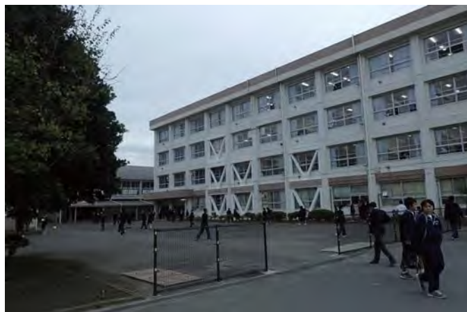
アプローチ（搬入通路）
