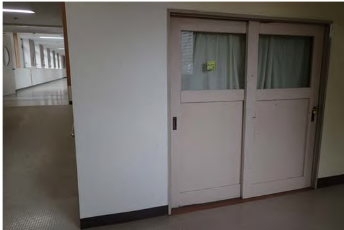
坂本棟廊下（エレベーター想定場所）
