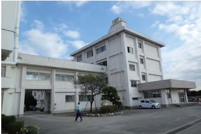
中庭入口（搬入経路）
