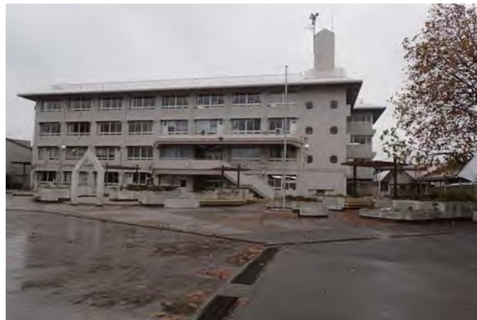
管理棟（着梯あり）
