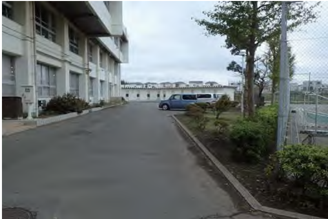
アプローチ（搬入通路）
