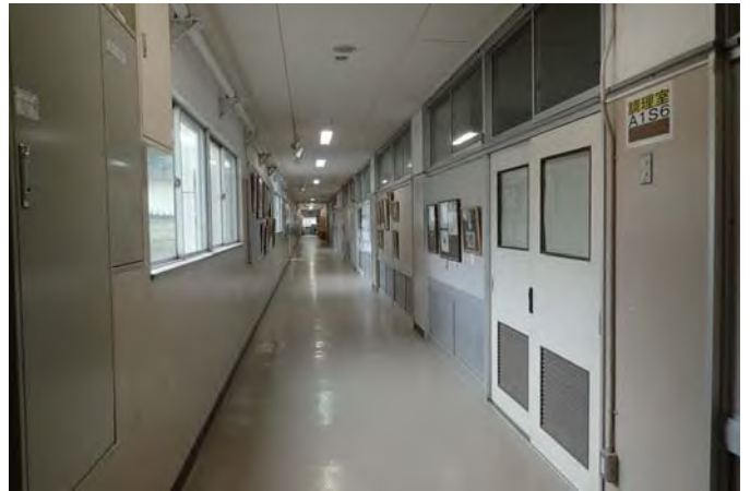
A棟校舎入口（運搬通路）
