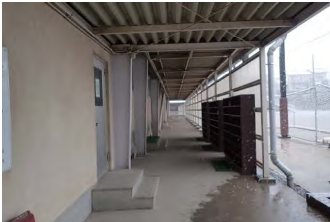
体育館渡り廊下（運搬経路）
