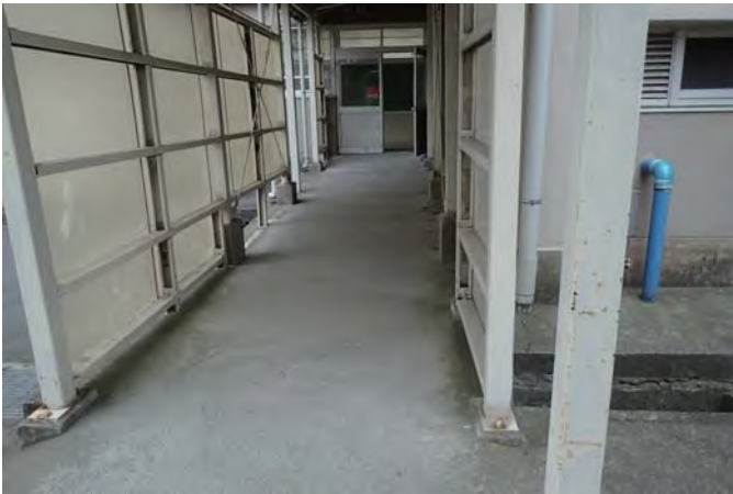
B棟校舎入口（運搬通路）
