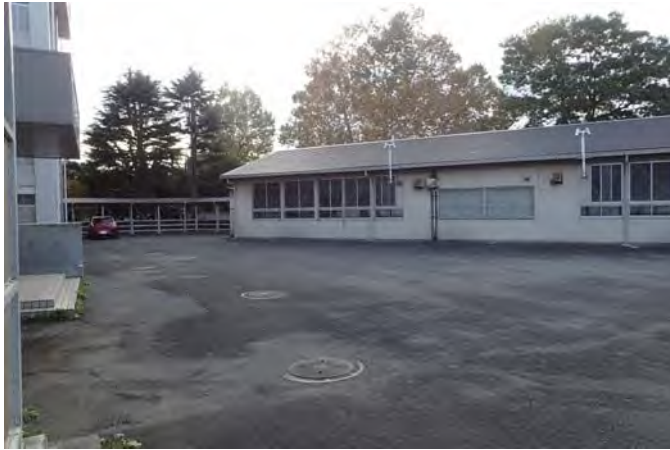
技術室棟（給食室候補場所）
