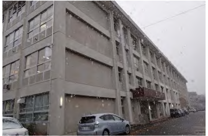
校舎南側（着梯あり）
