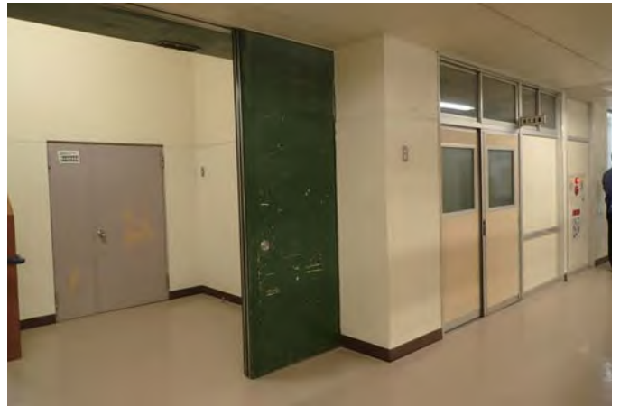
倉庫（エレベーター想定場所）
