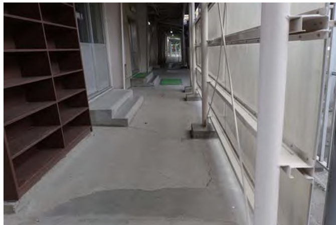
体育館場渡り廊下（運搬経路）
