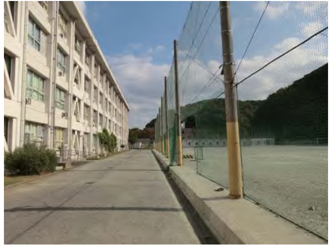
校舎南側（着梯あり）
