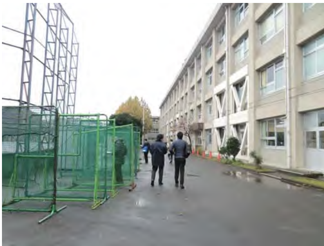
南側（着梯あり）
