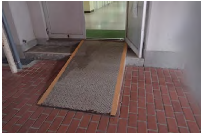
校舎西側入口（運搬経路）
