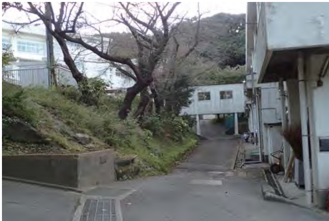
アプローチ（搬入通路）
