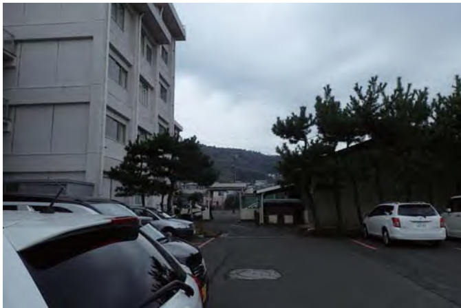
技術室棟と渡り廊下（給食室候補場所・運搬通路）
