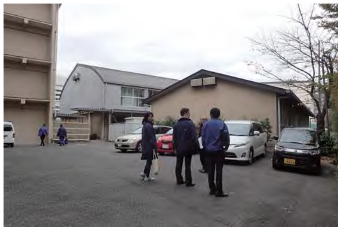
技術室棟（給食室設候補場所）
