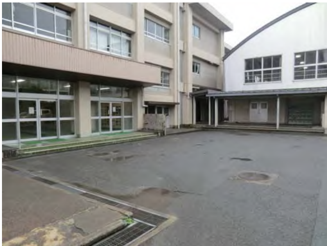
校舎北側・体育館
