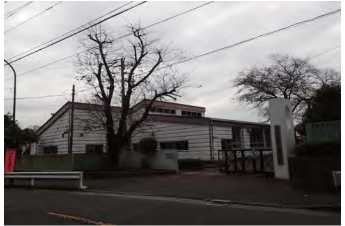
桜台棟正門（搬入経路）
