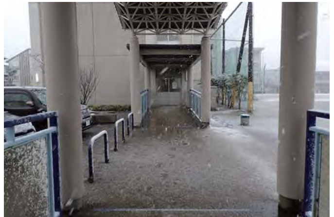
校舎入口（運搬経路）
