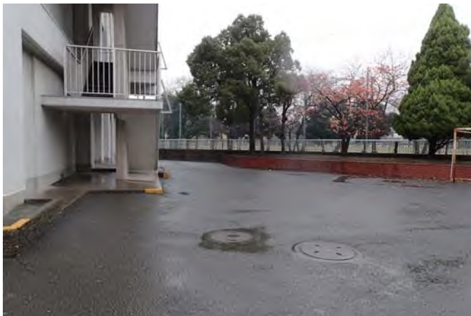
校舎東側通路（搬入通路）
