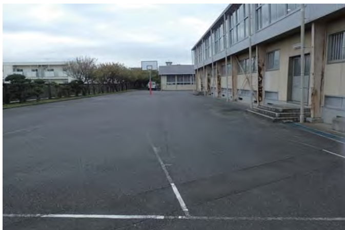
アプローチ（搬入通路）
