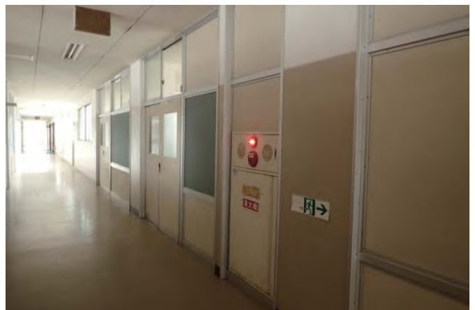
北棟廊下（運搬経路）
