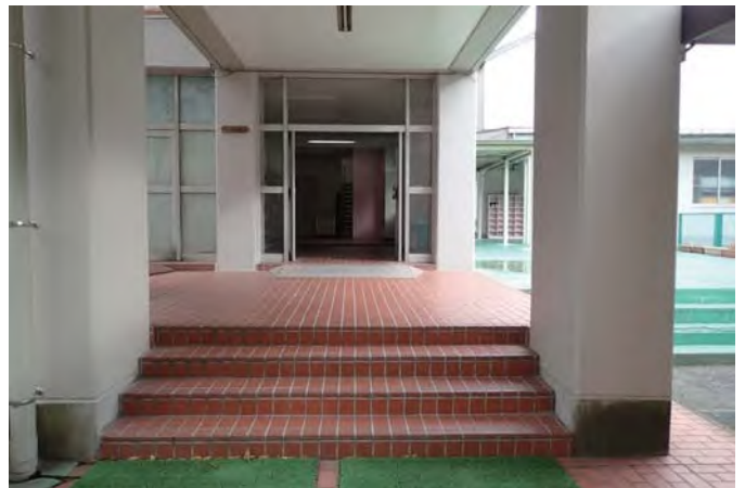
A 棟校舎入口（運搬通路）
