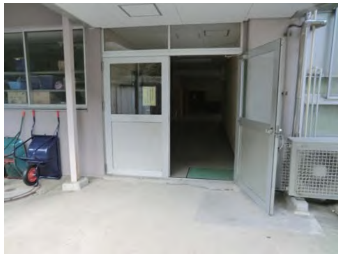
校舎A棟入口（運搬経路）
