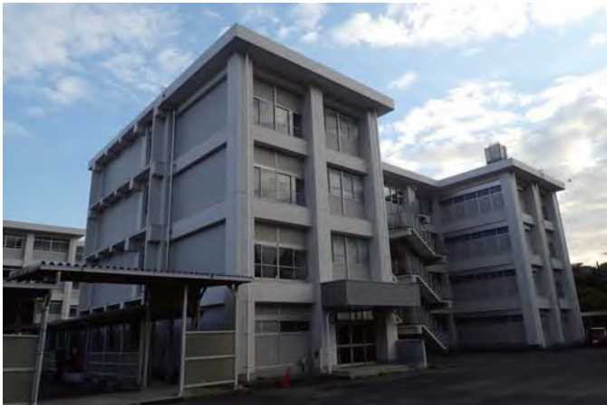
C棟（着梯あり）
