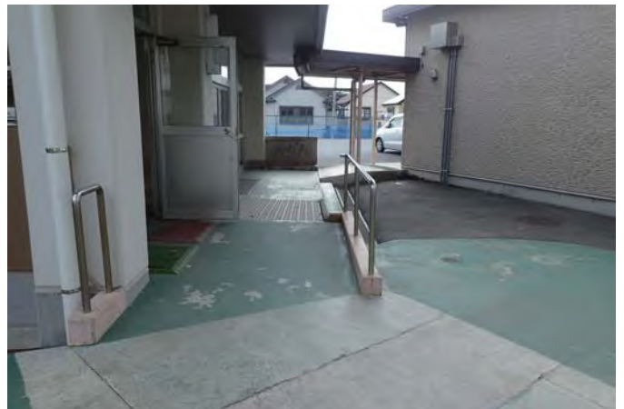
校舎入口（運搬通路）
