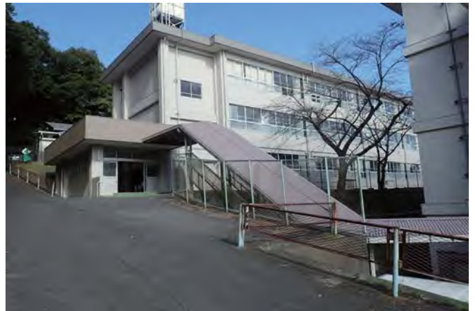
北棟西側渡り廊下
