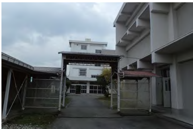
渡り廊下（運搬通路）
