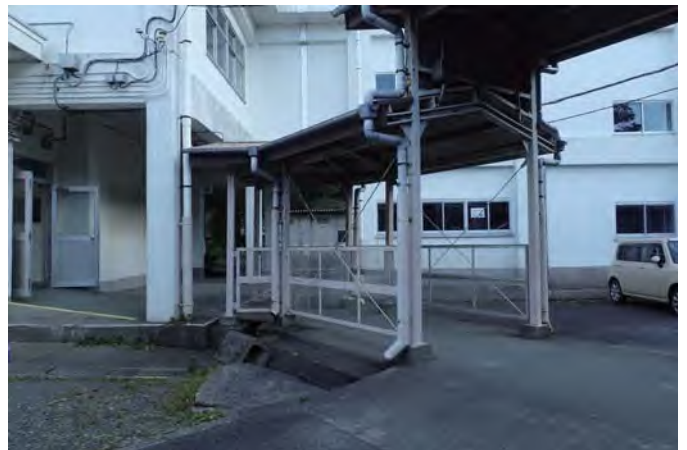
校舎入口（運搬通路）
