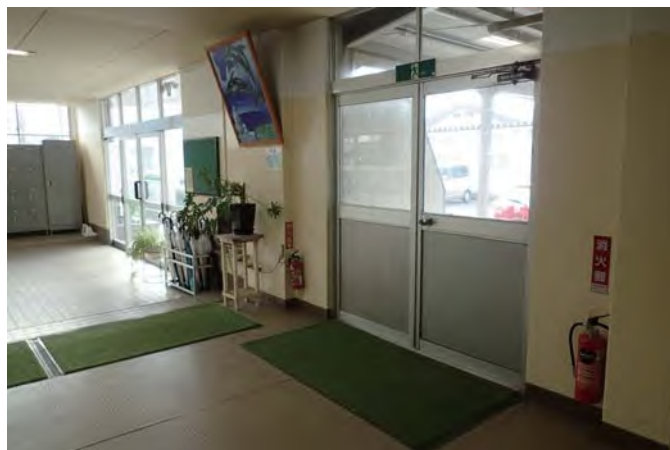
校舎入口（運搬経路）
