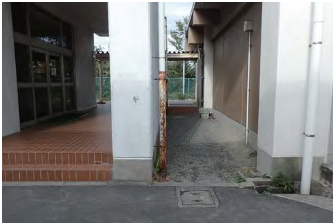
校舎入口（運搬通路）
