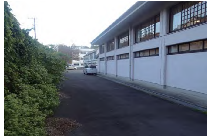
武道場北側通路（搬入経路）
