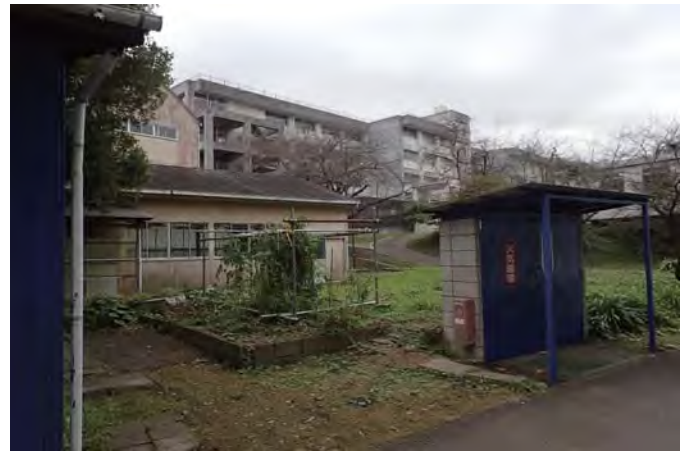
技術室棟（給食室候補場所）
