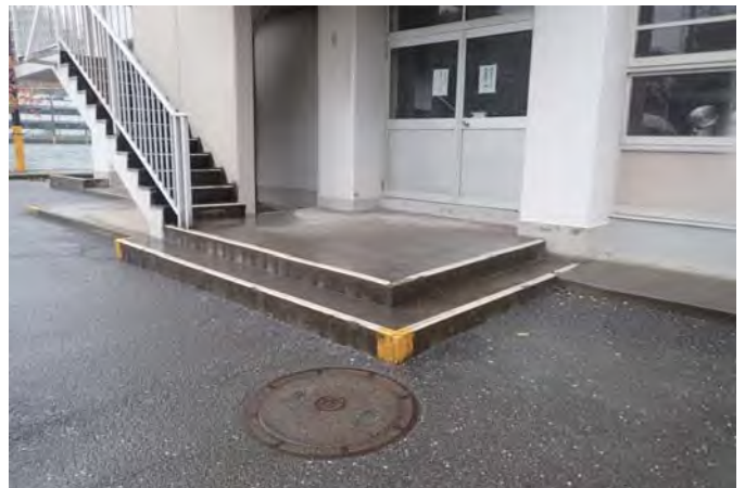
校舎東側入口（運搬経路）
