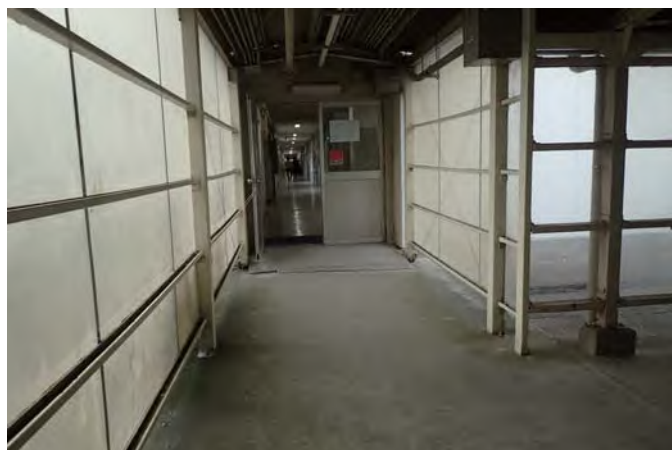
A棟校舎入口（運搬通路）
