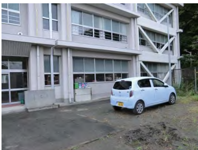
作業室外観（受け入れ口）
