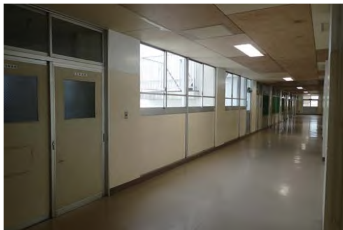
3階廊下（エレベーター想定場所）
