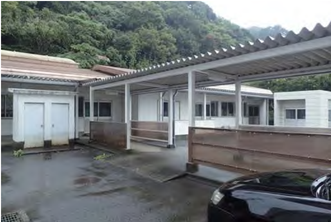
アプローチ（搬入通路）
