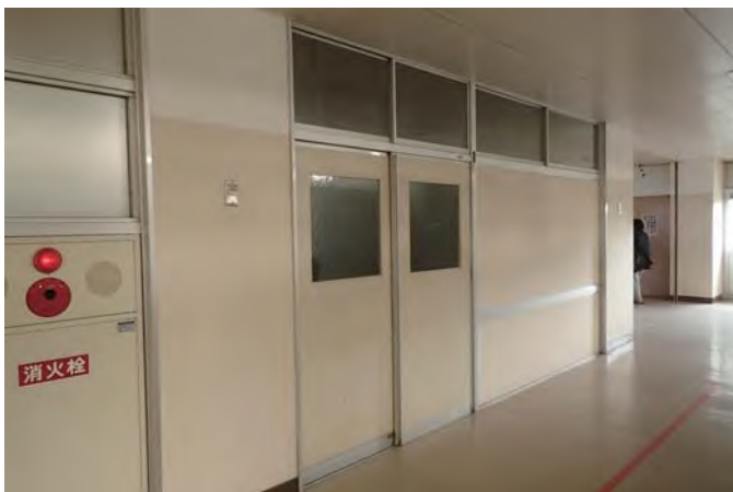
C棟女子更衣室（エレベーター想定場所）
