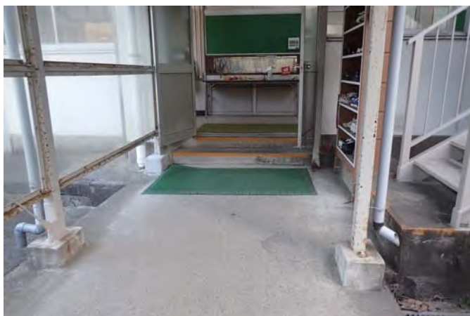
校舎入口（運搬経路）
