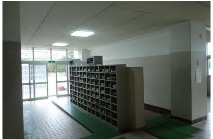
北側玄関（エレベーター想定場所）
