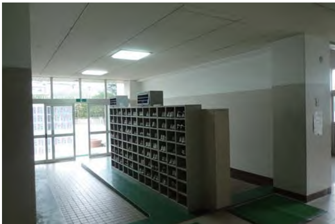
北側玄関（エレベーター想定場所）
