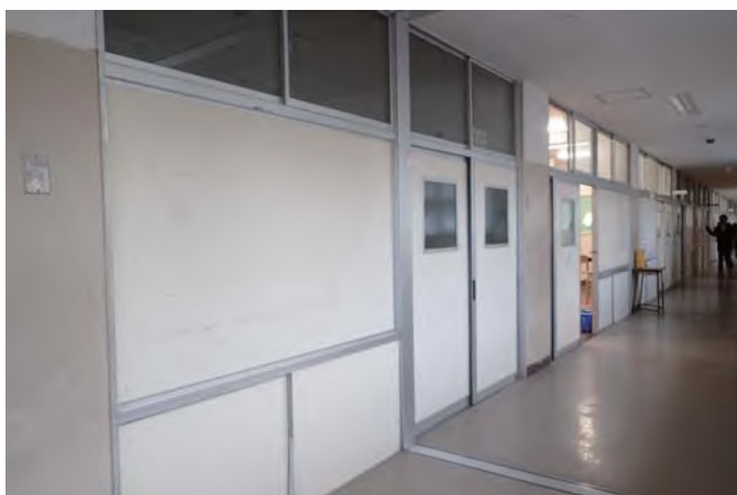
A棟廊下（エレベーター想定場所）
