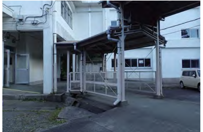
校舎入口（運搬通路）
