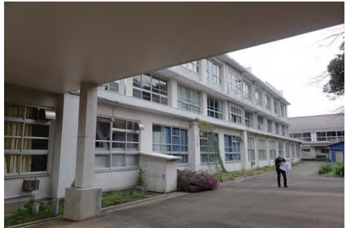
坂本棟南側（搬入経路・運搬経路）
