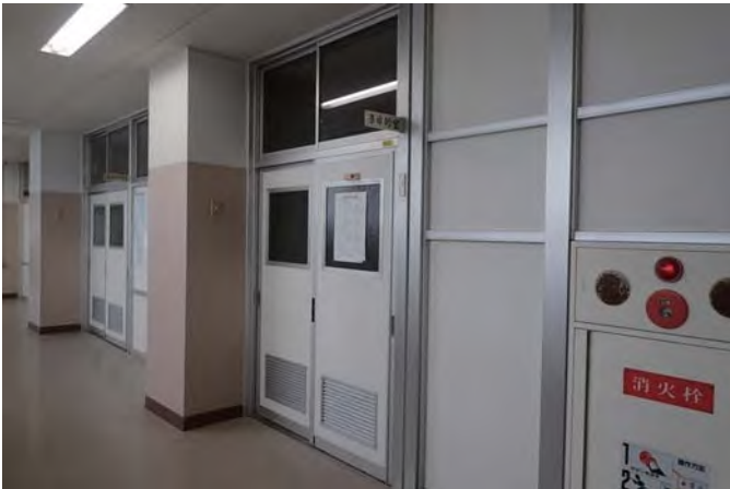
廊下（エレベーター想定場所）
