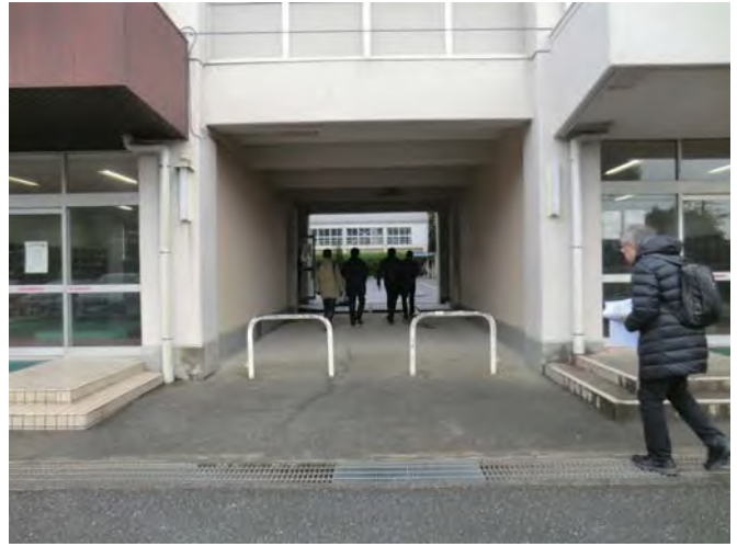
中庭入口（搬入経路）
