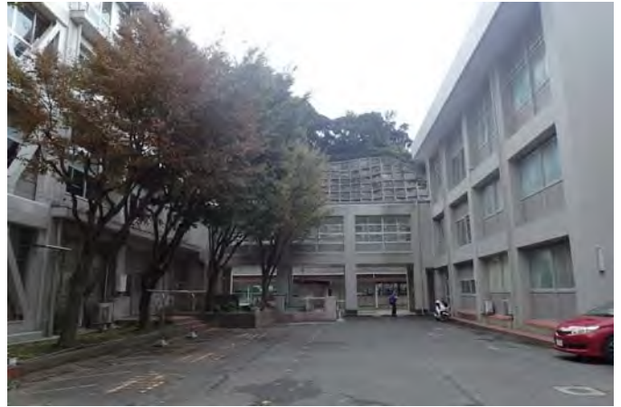
アプローチ（搬入通路）
