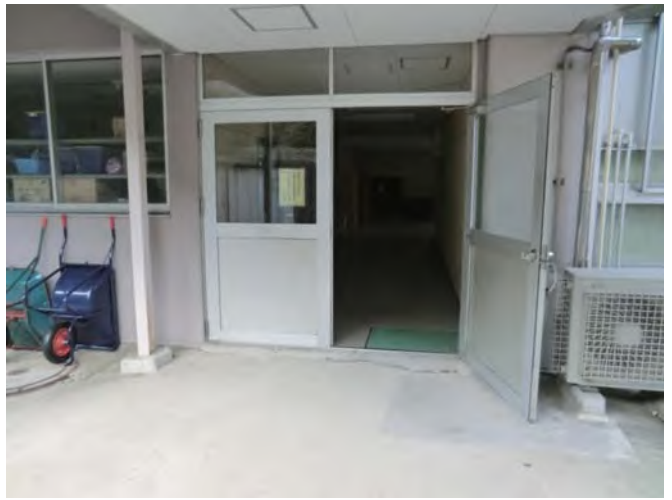
校舎A棟入口（運搬経路）
