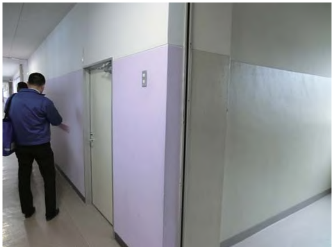
校舎2階（エレベーター想定場所）
