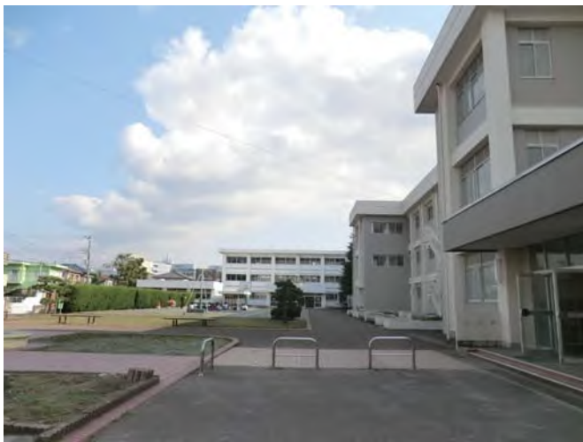
校舎B棟北側（給食室候補場所）
