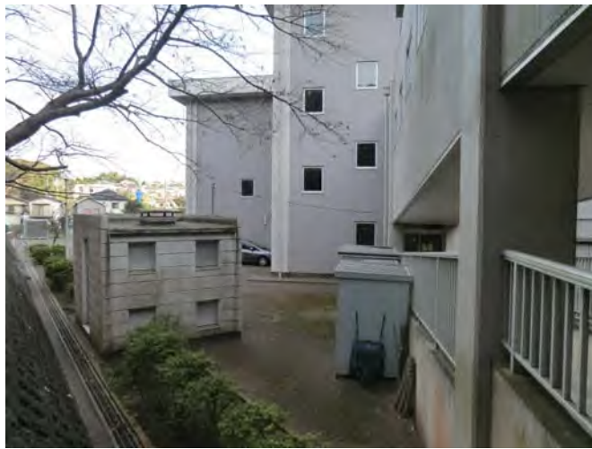
灯油庫（受け入れ建物設置場所）
