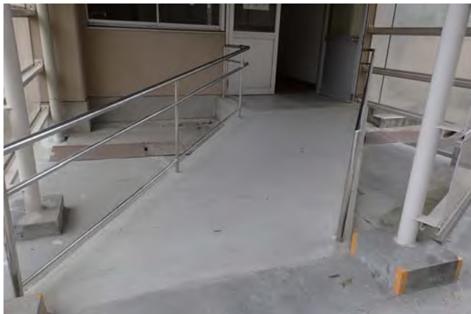
校舎入口（運搬経路）
