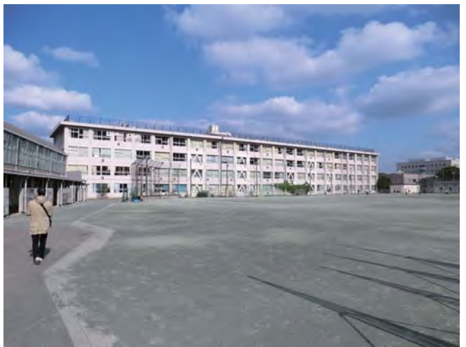
校舎南側全景
