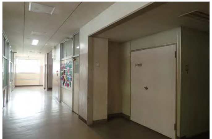
B棟廊下（エレベーター想定場所）
