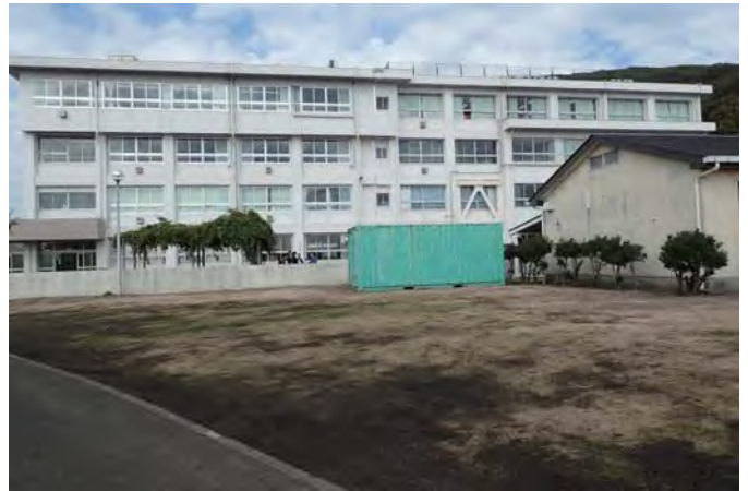
校舎南側全景
