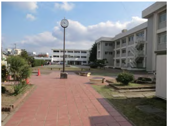
校舎B棟北側通路
