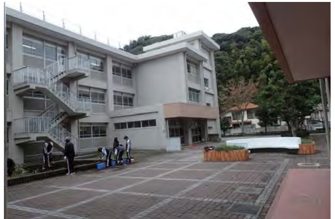
B-C 棟中庭（給食室候補場所）
