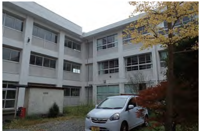
中庭と校舎入口（運搬通路）
