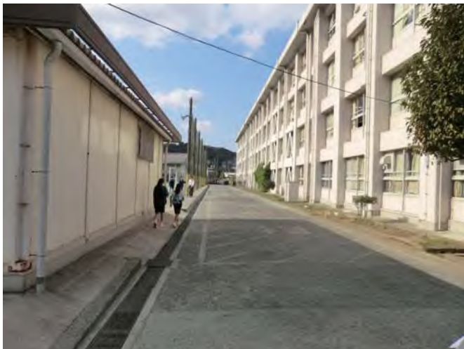
校舎南側（着梯あり）
