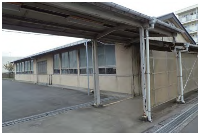
技術室棟南側
