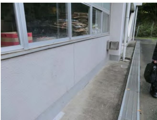
作業室外観（受け入れ口）
