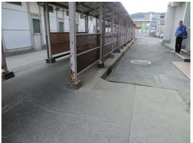
棟間渡り廊下（運搬経路）
