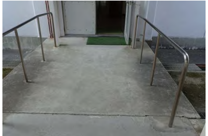
校舎入口（運搬経路）
