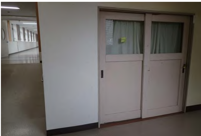
坂本棟倉庫（エレベーター想定場所）
