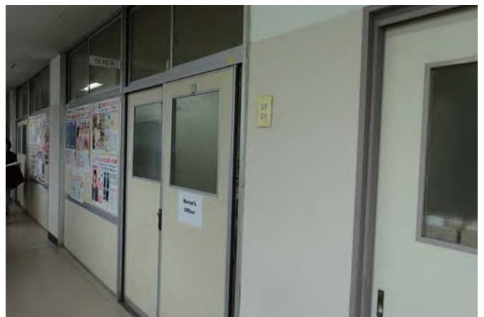
A 棟保健室（エレベーター想定場所）
