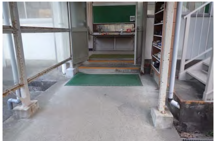
校舎入口（運搬経路）
