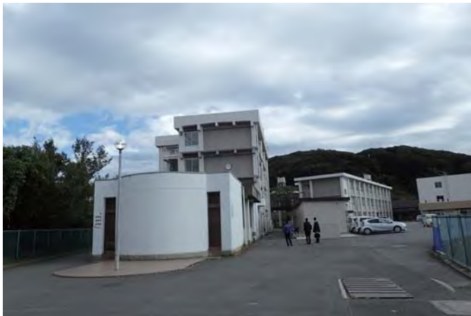
アプローチ（搬入通路）
