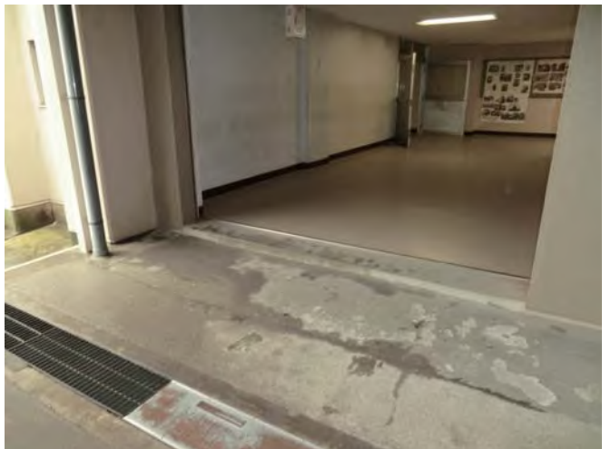
校舎北側入口（運搬経路）
