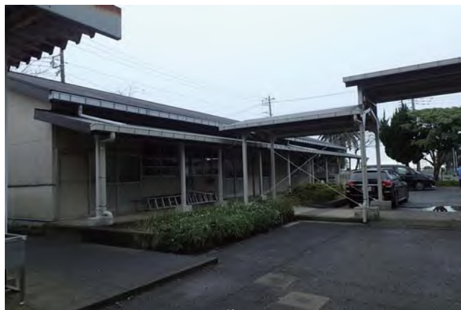
技術室棟（給食室候補場所）
