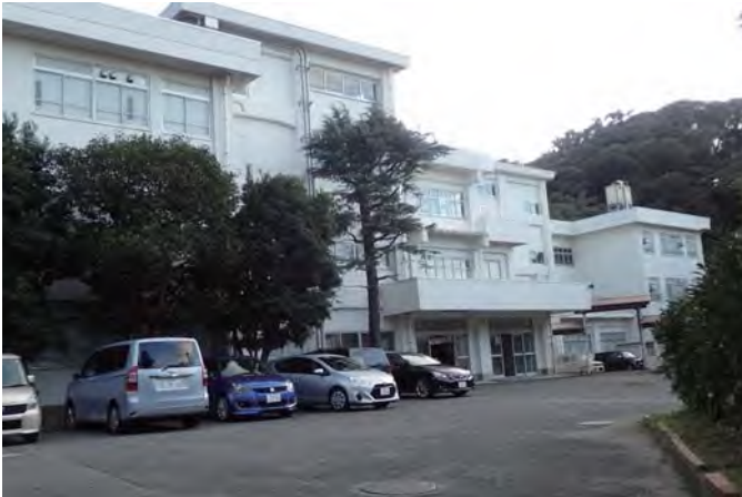
アプローチ（搬入通路）
