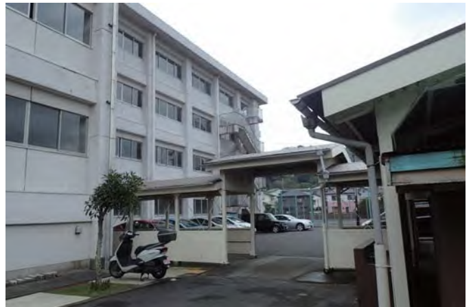
渡り廊下（運搬通路）
