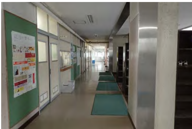
2棟事務室（エレベーター想定位置）
