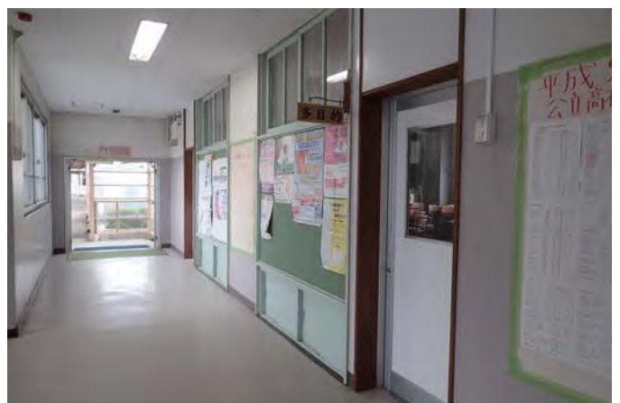
教室棟廊下（エレベーター想定場所）
