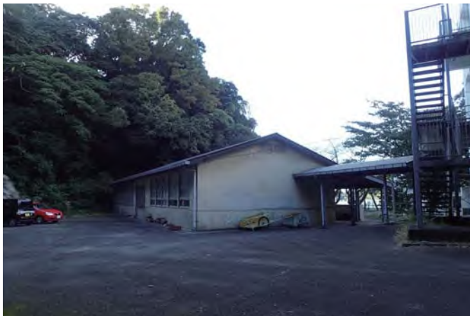
技術室棟（給食室候補場所）
