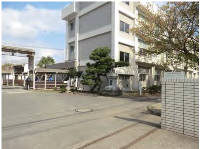
南側正門より見る
