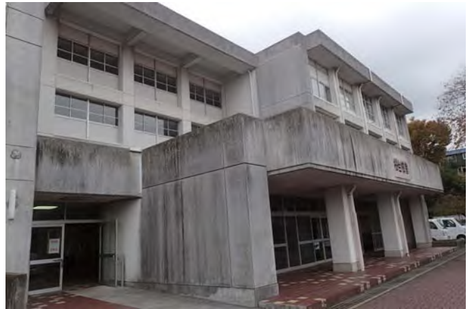
桜台棟入口（運搬経路）
