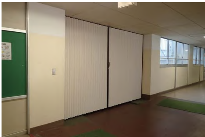
1階ホール（エレベーター想定場所）
