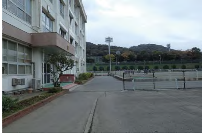
アプローチ（搬入通路）
