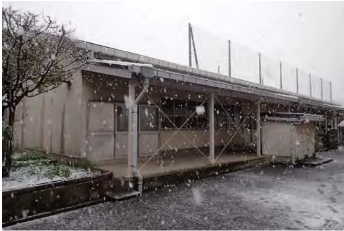
技術室棟（給食室候補場所）
