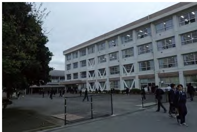
アプローチ（搬入通路）
