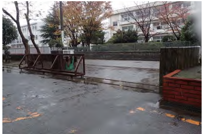
北側校門（校舎側より見る）
