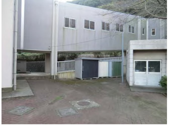
灯油庫（受け入れ建物設置場所）
