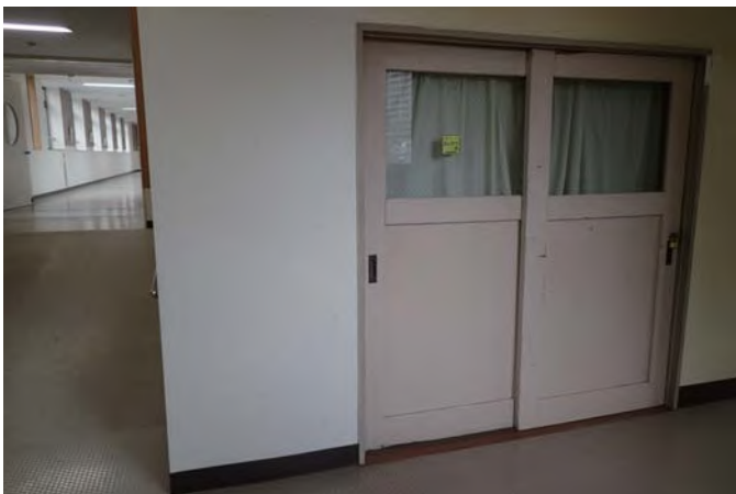
坂本棟廊下（エレベーター想定場所）
