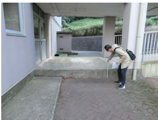
校舎入口段差（運搬経路）
