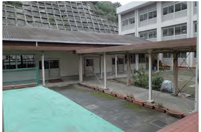
技術室棟（給食室候補場所）
