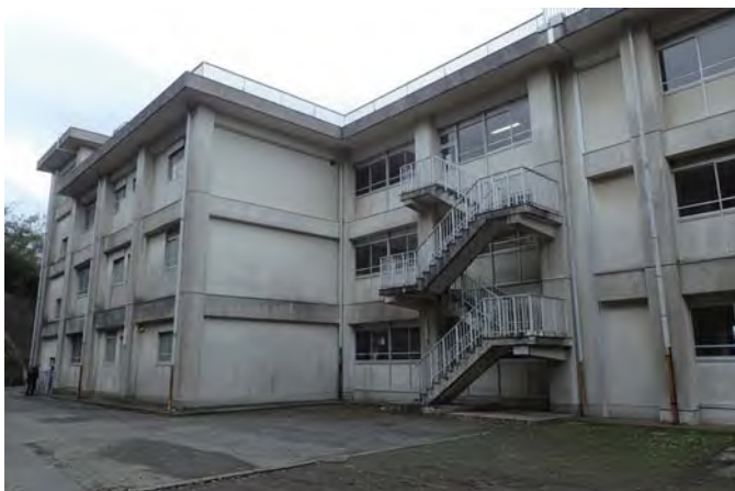
校舎入口（運搬通路）
