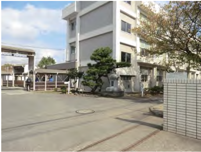
校地内通路（搬入経路）
