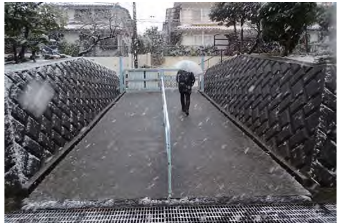
西側校門（校舎側より見る）
