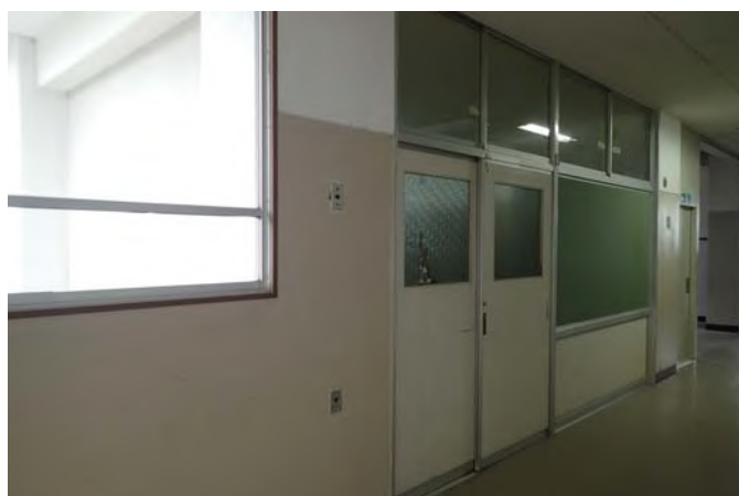
倉庫（エレベーター想定場所）
