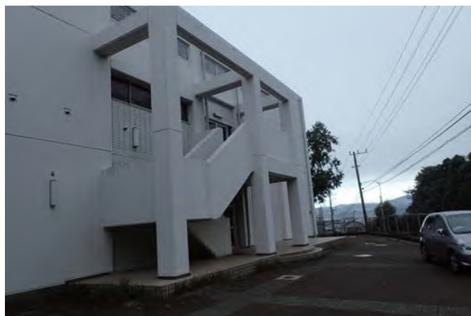
格技室棟東側
