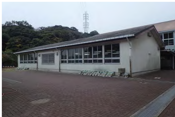
技術室棟（給食室候補場所）
