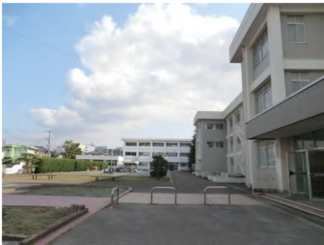
校舎B棟北側通路
