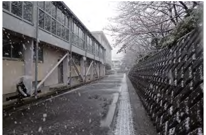
体育館西側通路（搬入経路）
