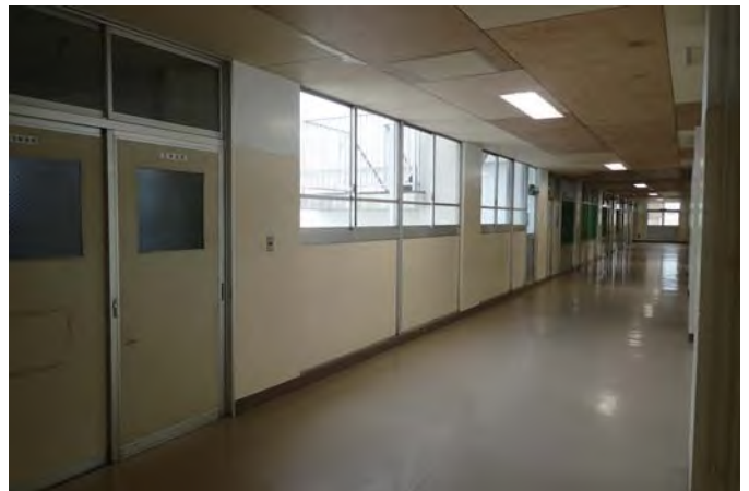
3階廊下（エレベーター想定場所）
