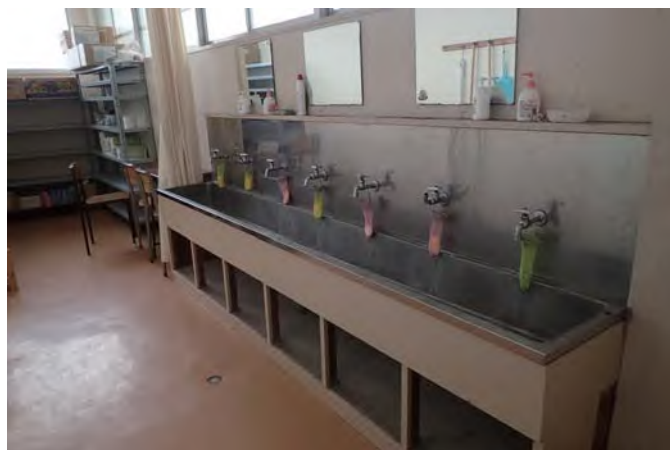
更衣室（エレベーター想定場所内部）
