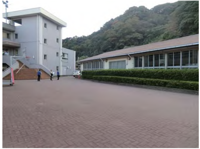
技術室棟（給食室候補場所）
