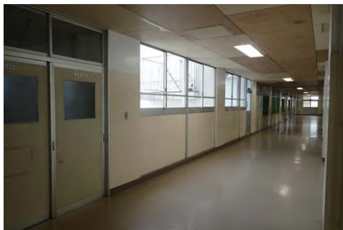
3階廊下（エレベーター想定場所）
