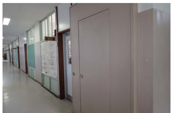
教室棟廊下（エレベーター想定場所）
