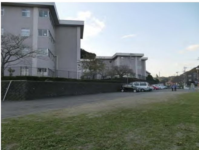
西側からの全景
