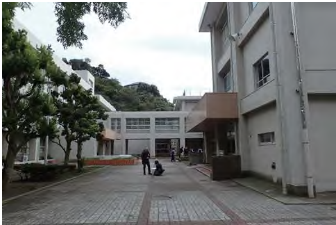
B-C 棟中庭（給食室候補場所）
