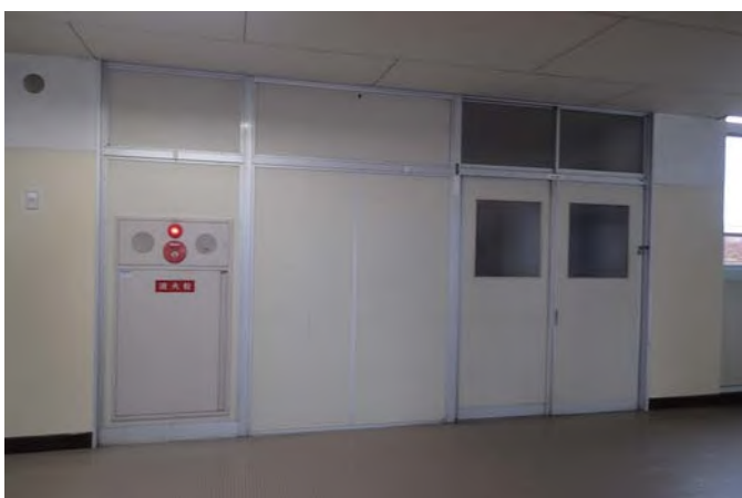
廊下（エレベーター想定場所）
