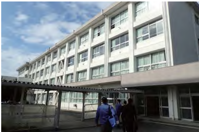
校舎入口（運搬経路）
