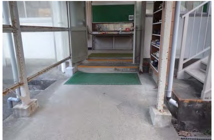
校舎入口（運搬経路）
