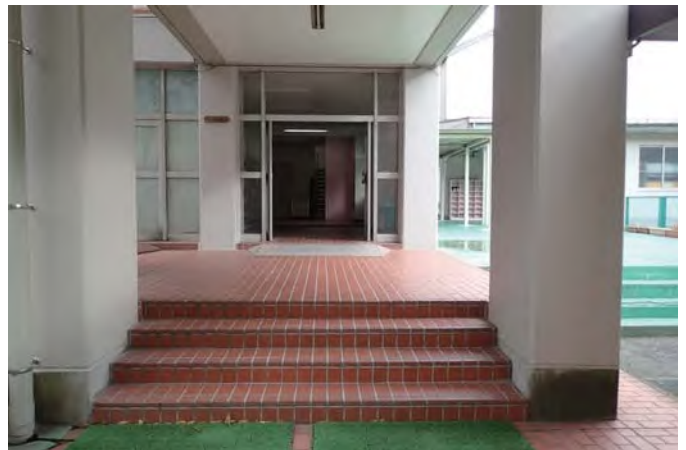
A棟校舎入口（運搬通路）
