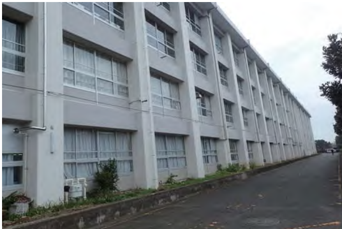
校舎南側（着梯あり）
