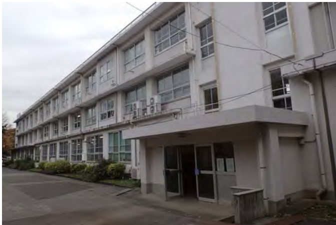
坂本棟南側（搬入経路）
