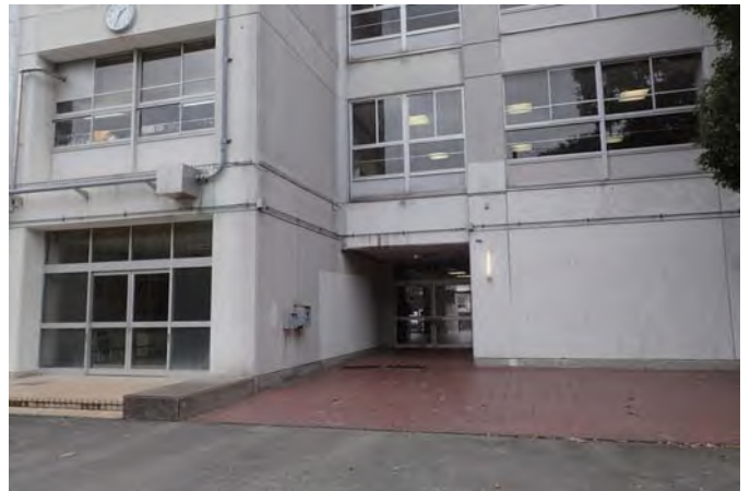
桜台棟南側（搬入経路）
