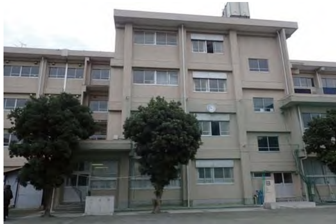
保健室外観（運搬経路）
