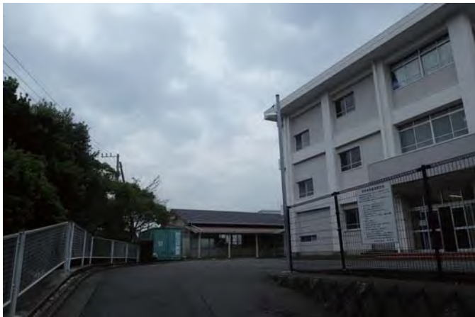
アプローチ（搬入通路）
