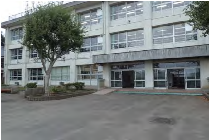
校舎入口（運搬通路）
