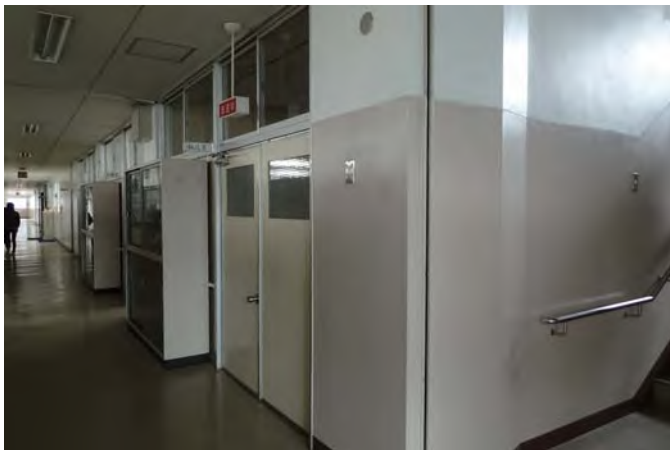
A棟2階廊下（エレベーター想定場所）
