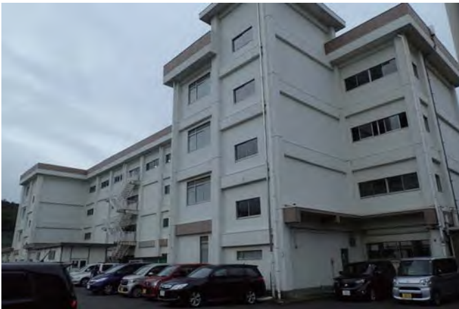
アプローチ（搬入通路）
