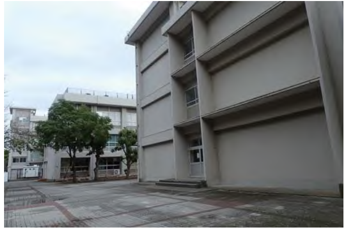
アプローチ（搬入通路）
