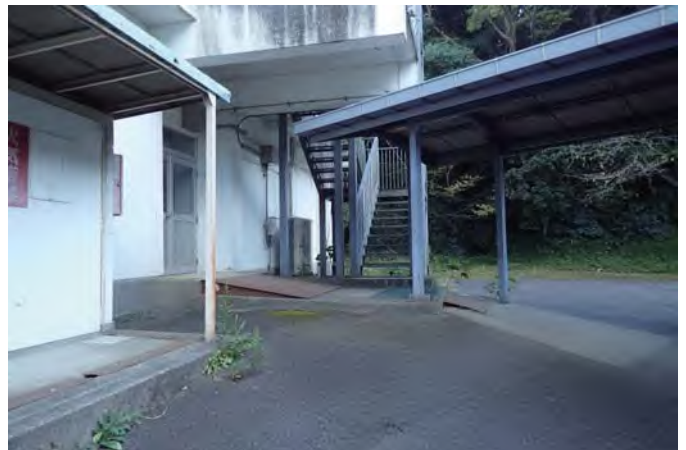
校舎入口（運搬通路）
