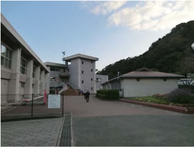
校地内通路と技術室棟（運搬経路・給食室候補場所）
