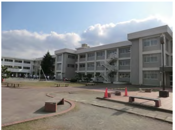
校舎B棟北側（給食室候補場所と搬入口）
