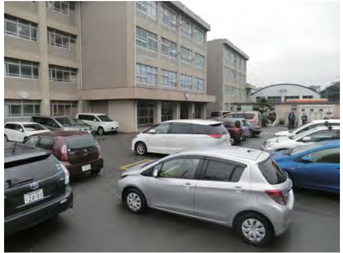
校舎北側（玄関側）
