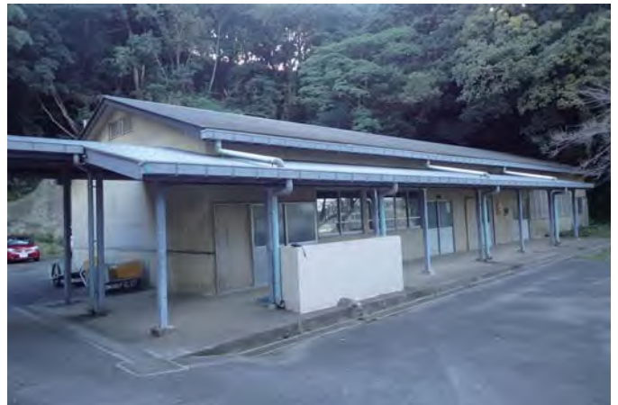
技術室棟（給食室候補場所）
