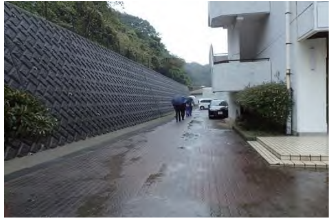
アプローチ（搬入通路）
