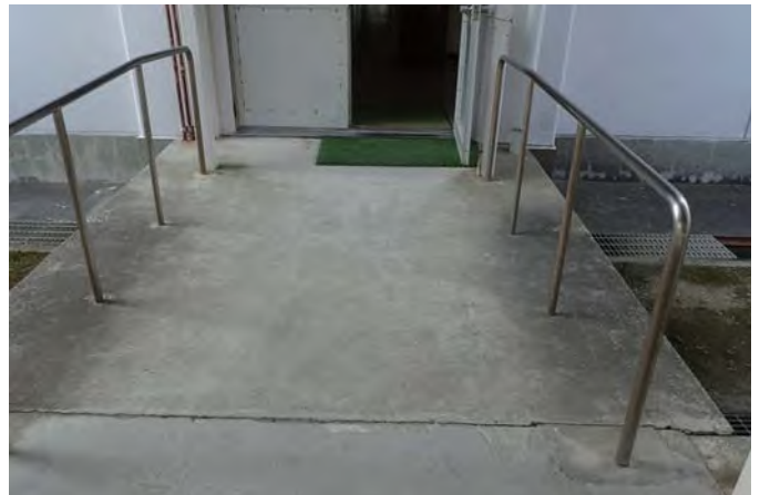
校舎入口（運搬経路）
