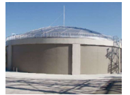
● 逸見高区配水池
