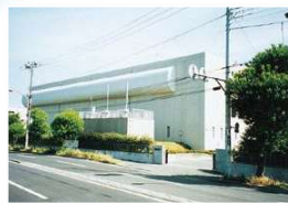
● 9 舟倉第2ポンプ場
