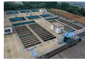
傾斜板沈でん池
