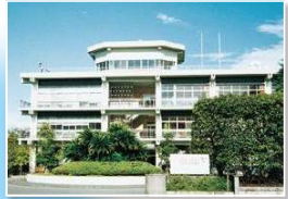
● 下町浄化センター
