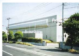
舟倉第2ポンプ場
