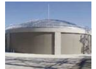
●逸見高区配水池
