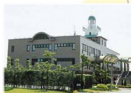
西浄化センター
