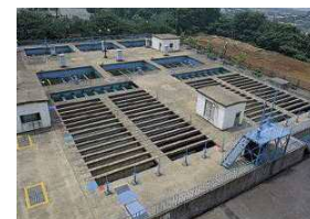
傾斜板沈でん池
