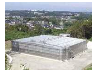
●久里浜配水池
