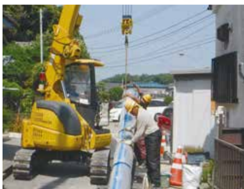
災害に強い管になるよう、工事を進めています。
